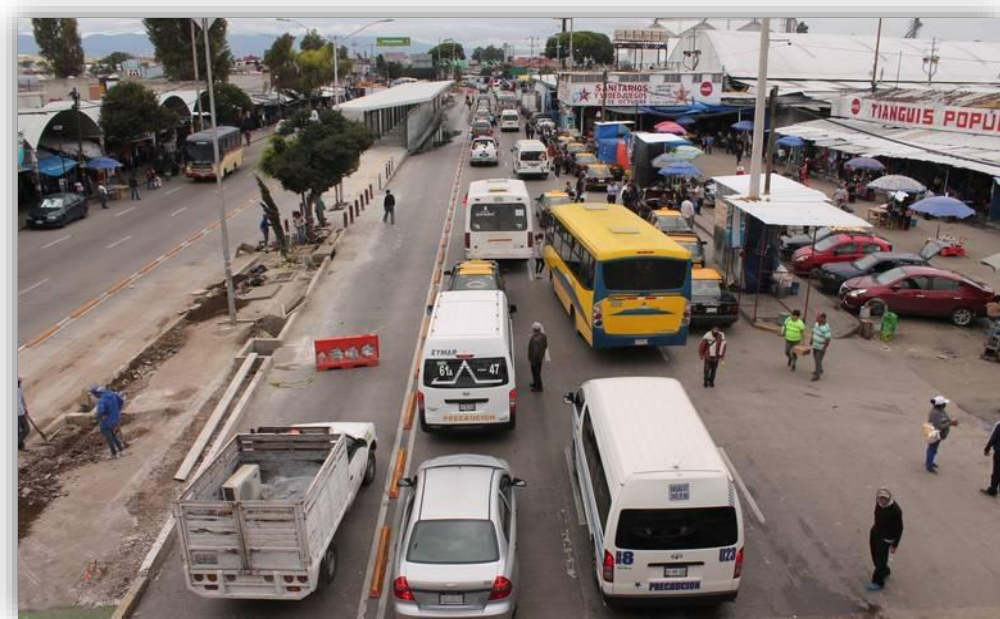
IMAGEN 3, NO DESIGNACIÓN DE CARRILES EN EL BOULEVARD NORTE CON SENTIDO A LA CAPU GOOGLE MAPS, 2018
