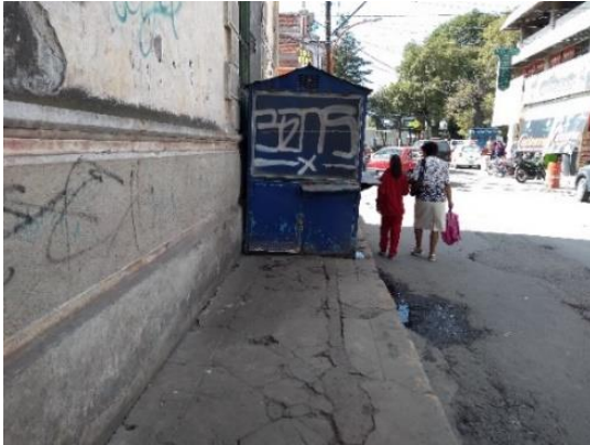
Kiosco de comercio informal sobre la acera peatonal
