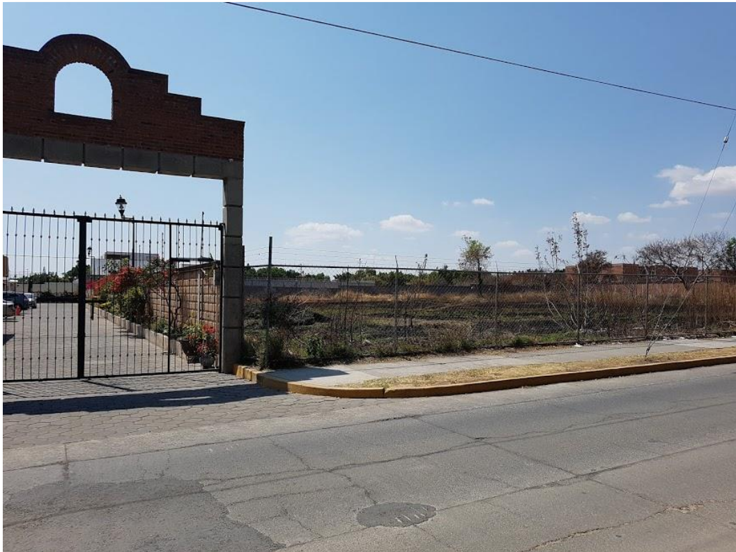
Foto N°7. Predio D y colindancia con fraccionamiento. Fuente: Elaboración propia.
