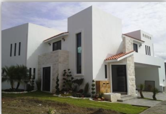
Fotografía no. 16 Fachada principal y fachada lateral derecha. (Vargas, 2013)
