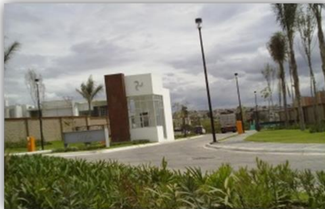
Fotografía no. 58 Acceso interno del fraccionamiento Lomas de Angelopolis. (Vargas, 2013)
