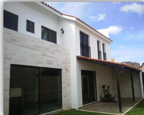
Fotografía no. 17 Fachada posterior. (Vargas, 2013)
