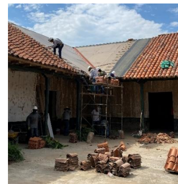
Figura 28. Rehabilitación de la Factoría, Ambalema, Colombia Fuente: Fátima Sánchez, julio 2024.
