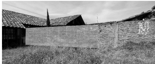
Figura 45. Reinterpretación de muro divisorio en zona del patio. Fuente: Fátima Sánchez, septiembre 2025.
