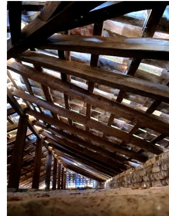
Figura 66. Entramado de madera de la cubierta. Fuente: Fátima Sánchez, marzo 2025.
