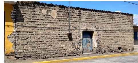
Figura 23. Construcción representativa de la arquitectura doméstica de adobe en Huaquechula, Puebla. Fuente: Enrique Benítez, septiembre, 2025.
