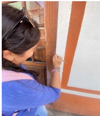
Figura 65 Elaboración de calas en fachada principal. Fuente: Fátima Sánchez, marzo 2025.
