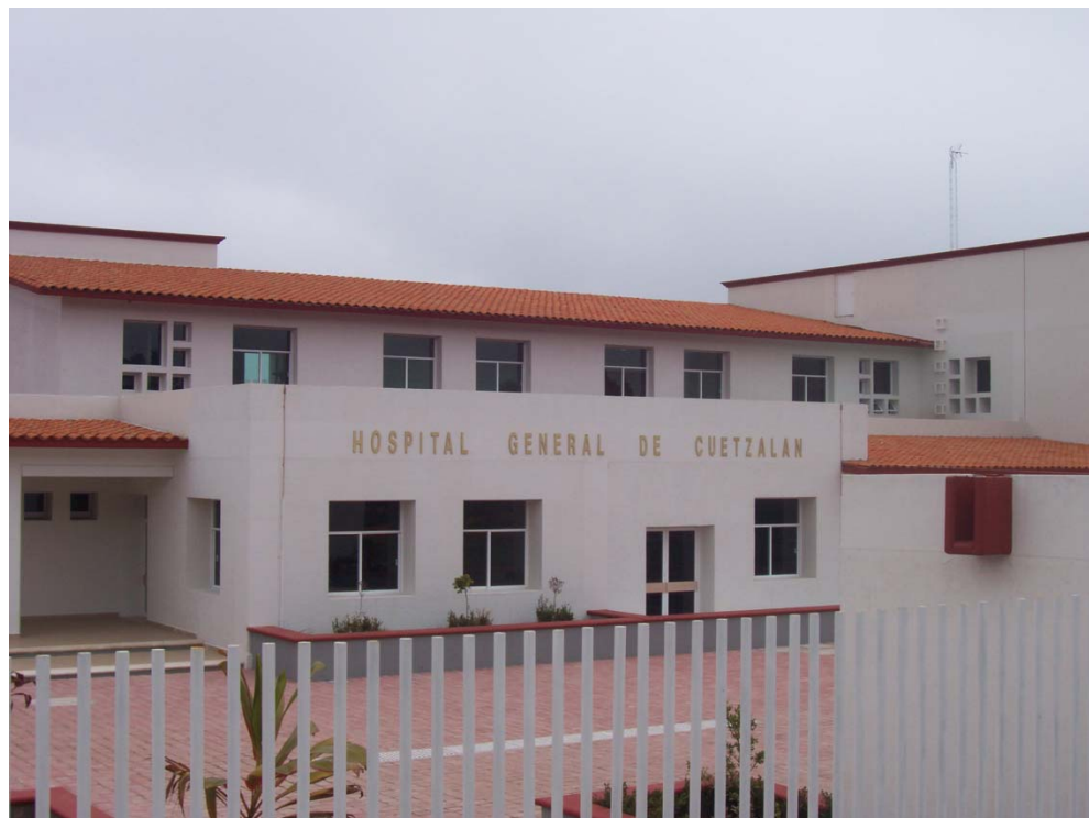
Figura 28. Vista del hospital desde el acceso peatonal
