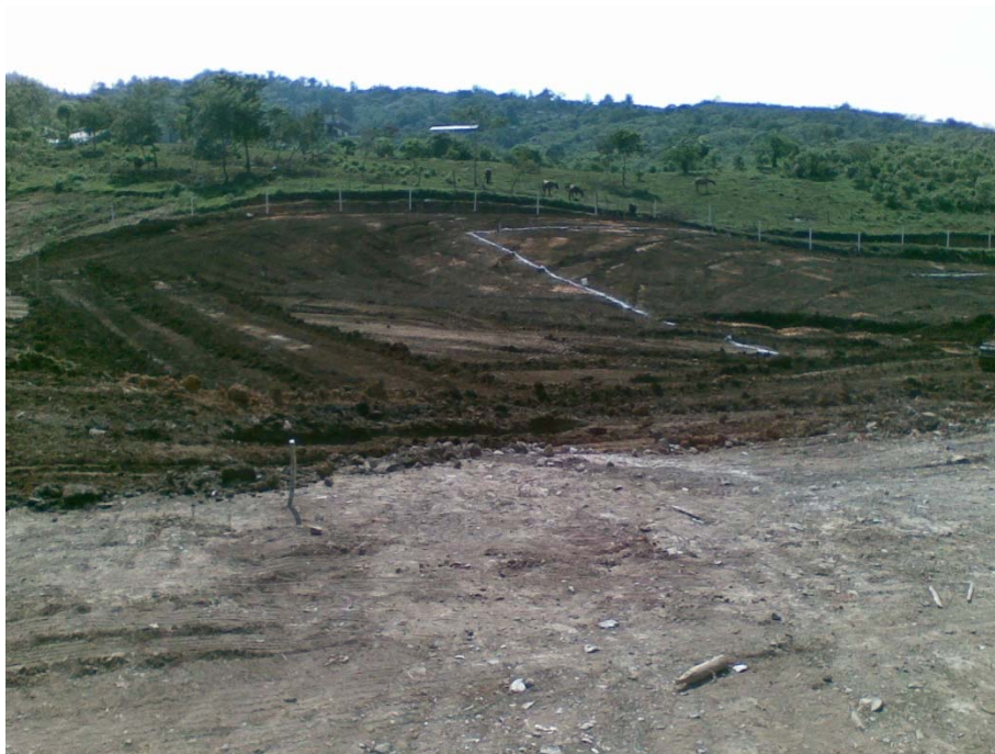
Figura 9. Vista del desnivel transversal en plataforma 2, vista oriente
