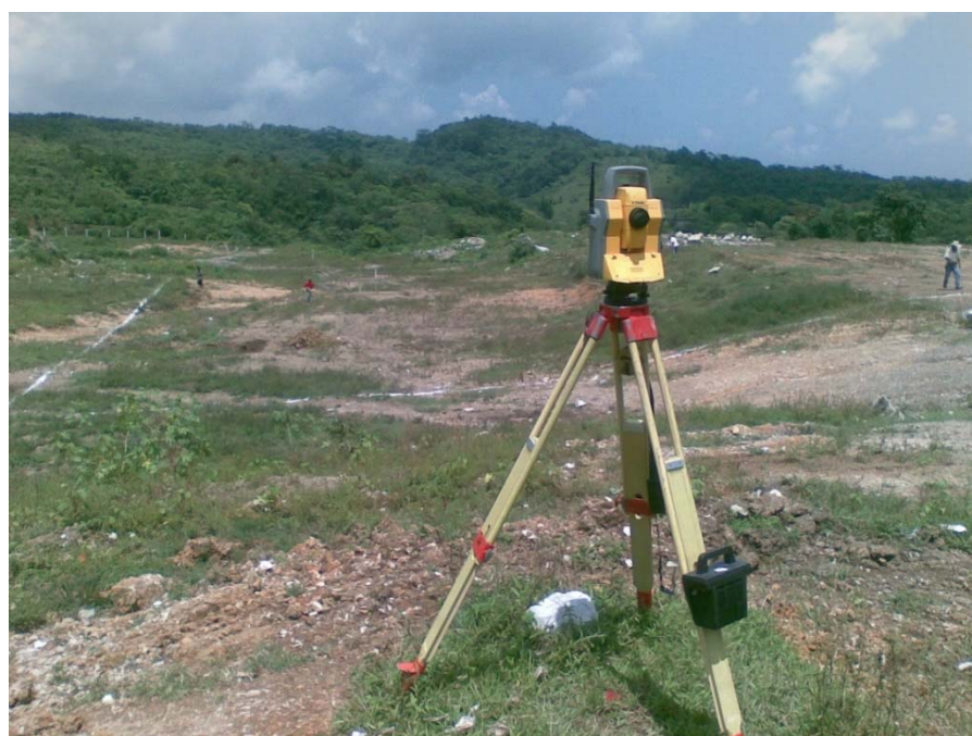
Figura 5. Vista del inicio de los trabajos de topografía
