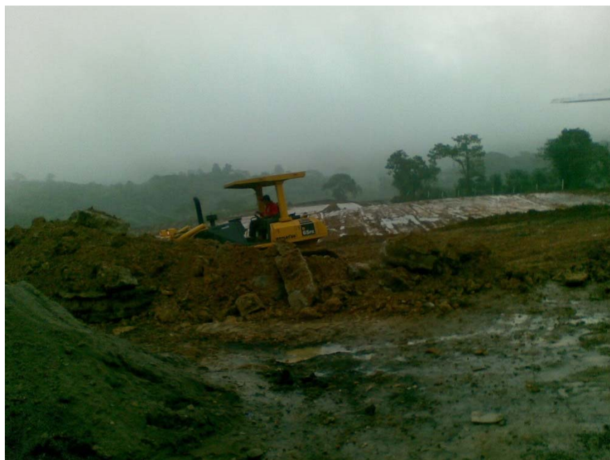
Figura 13. Área de escalonamiento. Vista de la plataforma 2
