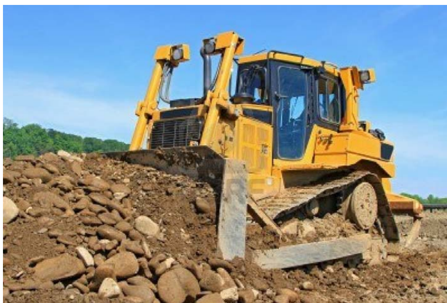
Figura 19. Tendido y conformación de material rocoso
