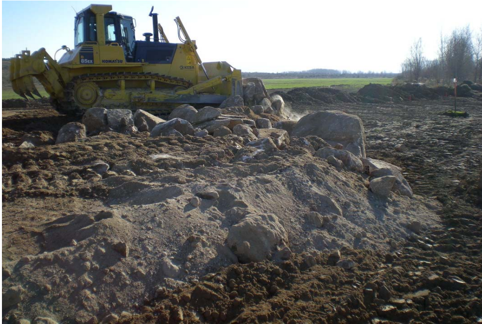
Figura 17. Pedraplén extendido y conformado con un bulldozer
