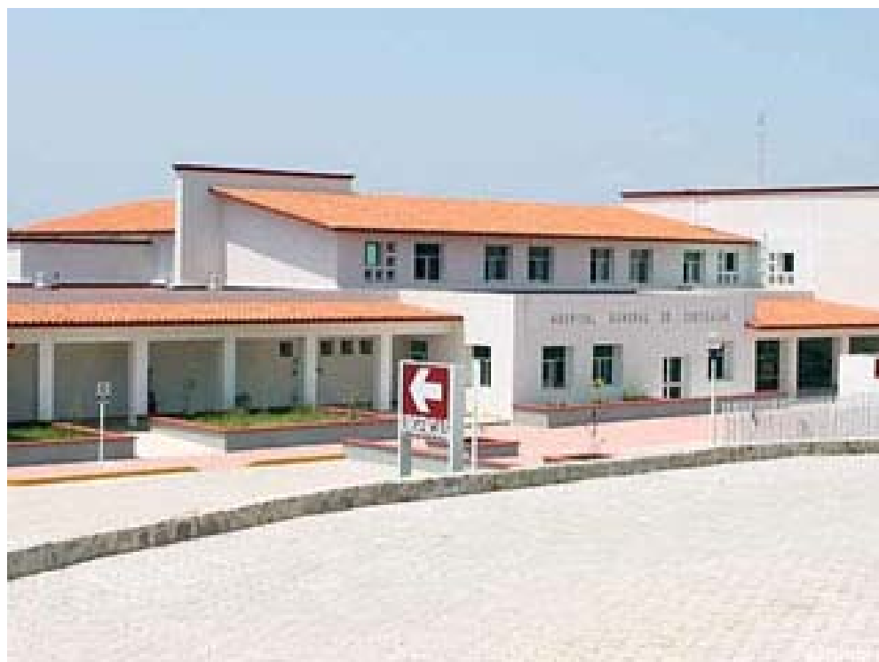
Figura 29. Vista del hospital desde el acceso vehicular
