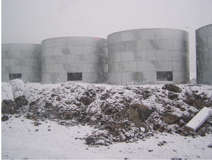
Figura 2.2: Construcción de los tanques de acero del Observatorio HAWC.
