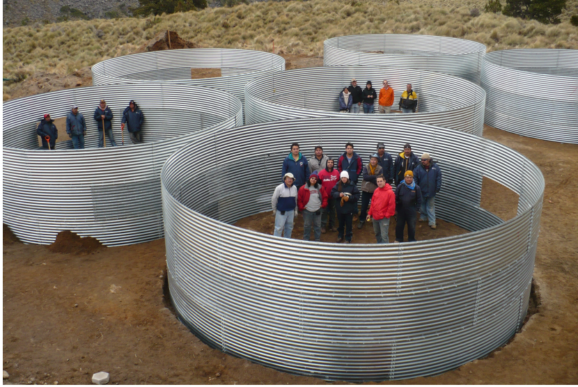
Figura 2.3: Construcción del prototipo VAMOS
