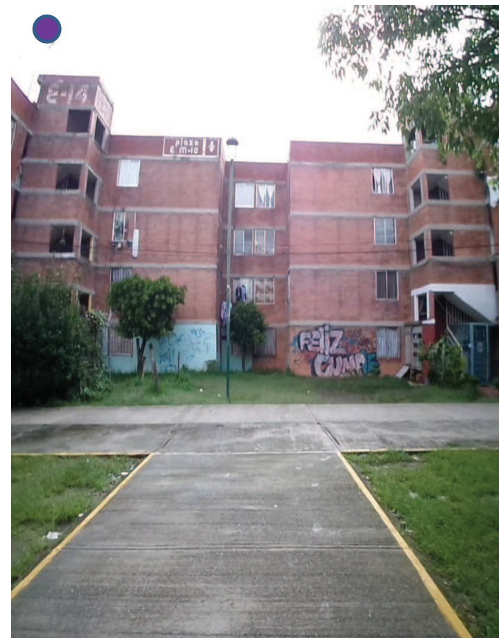
Figura 70 Conjunto de viviendas 2. Foto: VRA, 2014
