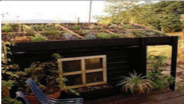
Figura 119 Imagen de azotea verde. Fuente: http://www.ecoportal.net/Temas_Especiales/Habitat_Urbano/ 6_Sencillos_Pasos_para_hacer_un_techo_verde
