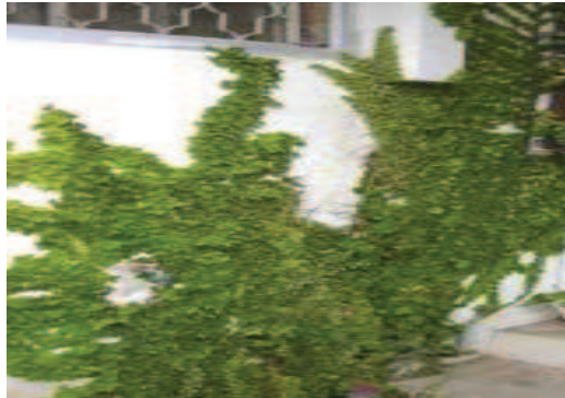
Figura 135 Muro verde con enredadera
