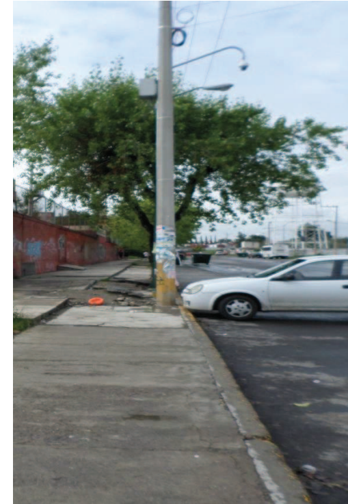
Figura 66 Luminaria en vialidad. Foto. VRA, 2014
