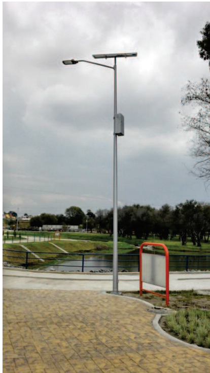
Figura 112 Luminaria solar para alumbrado público con un brazos de 30 Watts.
