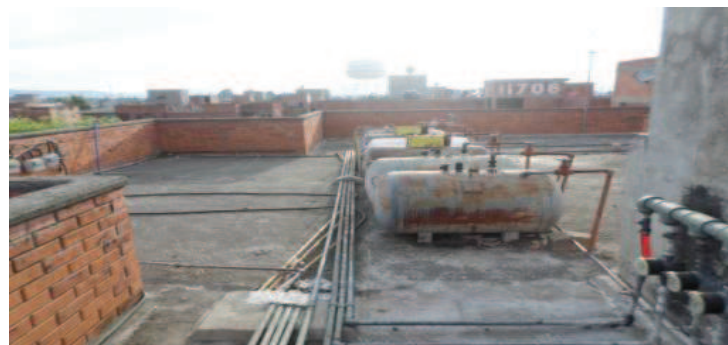
Figura 94: Azotea de viviendas de Agua Santa. Foto por: VRA, 2014
