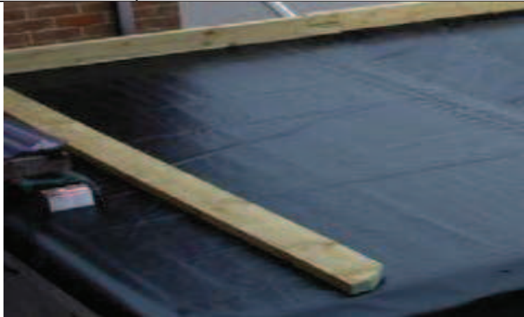
Figura 121 Capa impermeable. Fuente: http://www.ecoportal.net/Temas_Especiales/Habitat_Urbano/ 6_Sencillos_Pasos_para_hacer_un_techo_verde
