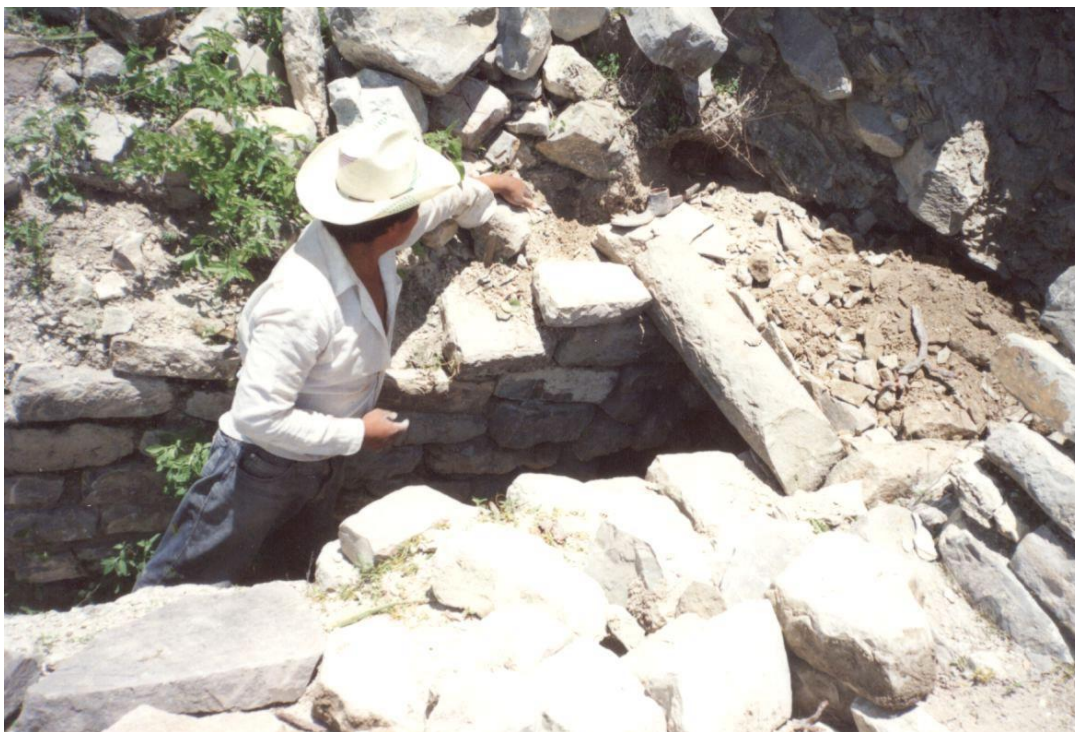
Figura 16 Excavación de 1993 para el arreglo de fachada en la tumba (2) del sitio de Cuthá. Fotógrafo Blas Castellón.
