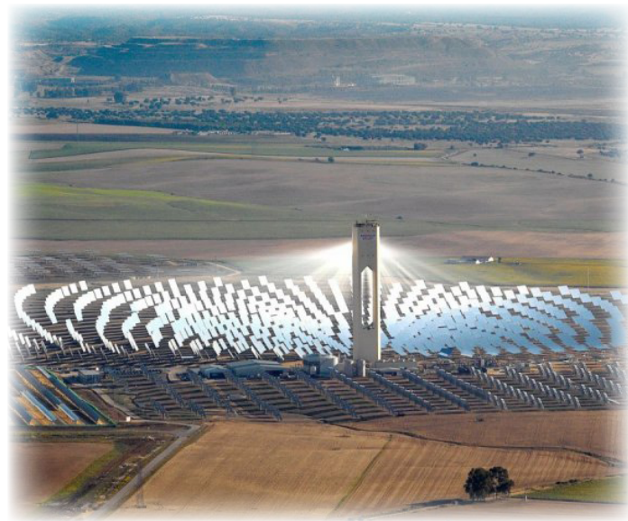
PLANTA DE ENERGÍA SOLAR SANLÚCAR LA MAYOR, SEVILLA ESPAÑA
