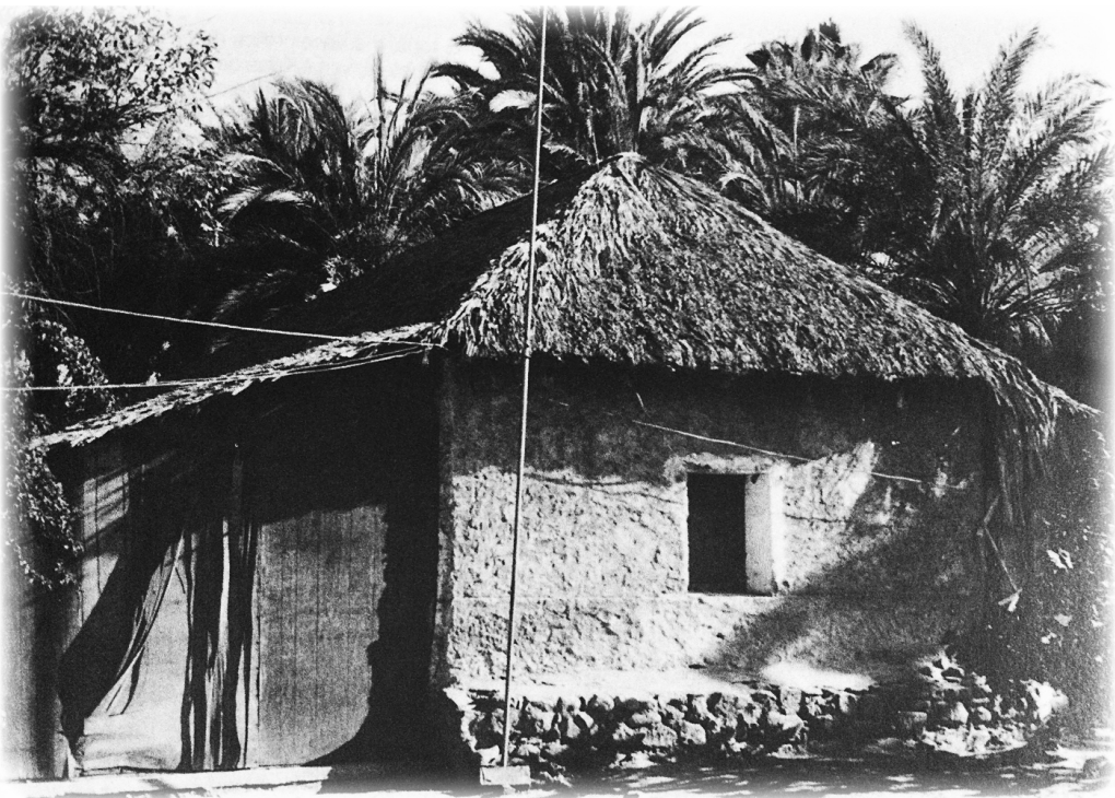
CASA DE ABOBE Y CUBIERTA VEGETAL EN LORETO BAJA CALIFORNIA SUR, TOMADA DEL LIBRO ARQUITECTURA VERNÁCULA EN MÉXICO AUTOR DESCONOCIDO
