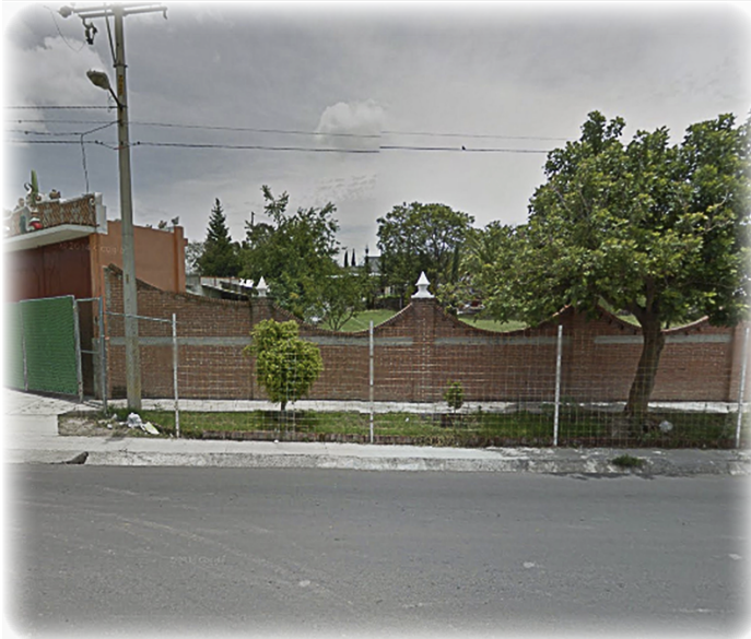
SAN PEDRO ZACACHIMALPA ASPECTO DE UNA CONSTRUCCIÓN MUY CERCANA A NUESTRO SITIO DE INTERVENCIÓN
