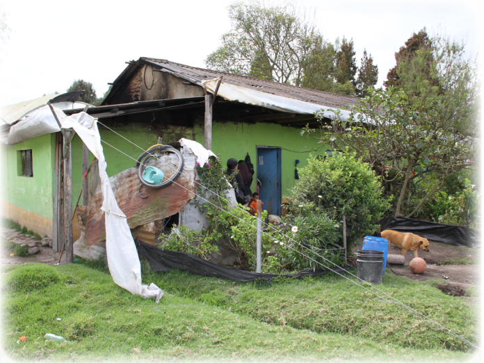
CASA EN EL MEDIO RURAL, QUE IMPLEMENTA MATERIALES PRE-FABRICADOS Y MANO DE OBRA ESPECIALIZADA
