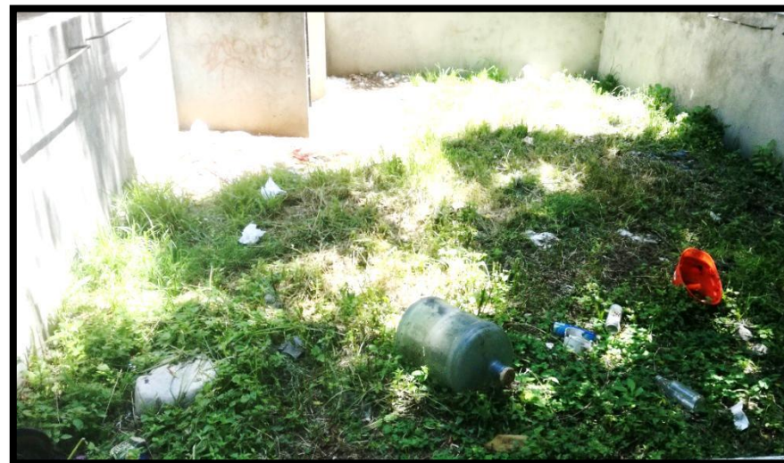
Estructura incompleta ocupada por indigentes. (Morales, 2017)
