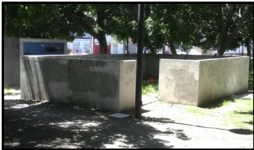
Estructura incompleta ocupada por indigentes. (Morales, 2017)
