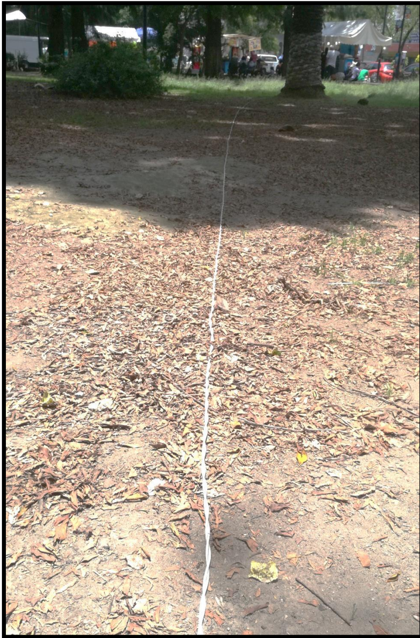
Robo de energía eléctrica. (Morales, 2017)
