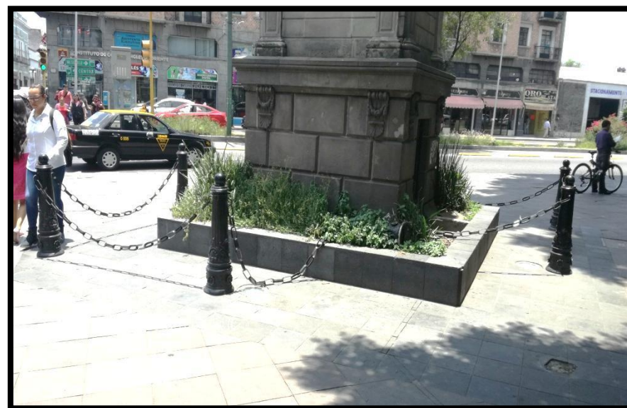
Poste de contención del gallito vandalizado. (Morales, 2017)
