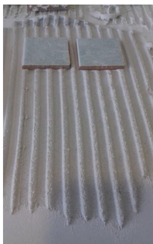
Figura 34. Colocación de piezas cerámicas
