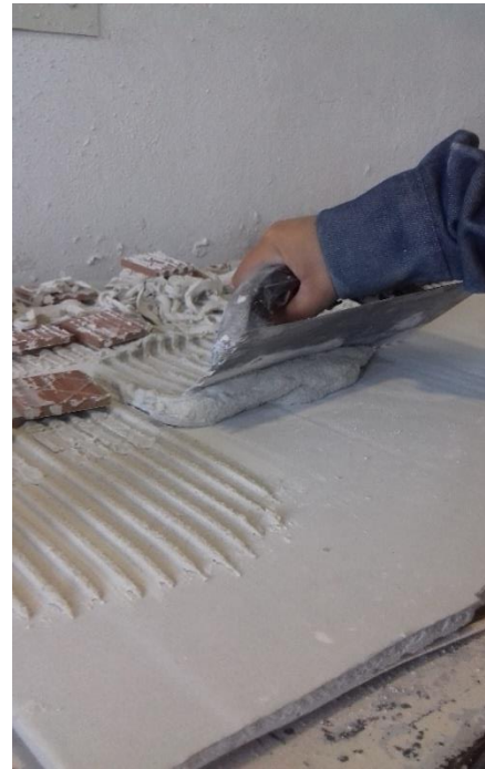
Figura 33. Aplicación de mezcla adhesiva
