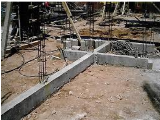
Imagen No. 75 Cadena de desplante terminada. Fuente: Técnicas de construcción, 2015
