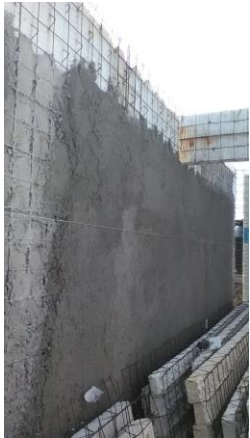
Imagen No. 80 Repellado de muro de panel Covintec. Fuente: Habitissimo, 2020
