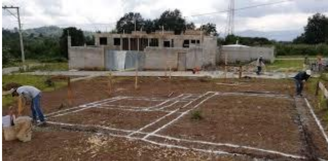
Imagen No. 64 Trazo y nivelación. Fuente: Google, 2020
