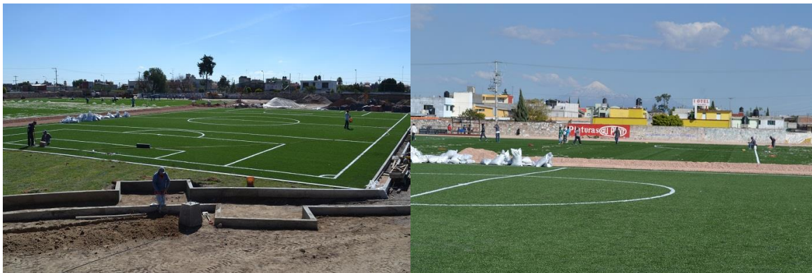
Imagen No. 18 y 19 Remodelación Unidad Deportiva Cardenales (Municipios, 2015)
