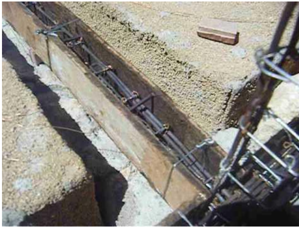
Imagen No. 74 Encajonamiento de cadena de desplante. Fuente: YouTube, 2018
