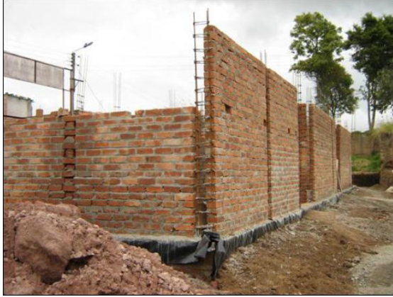
Imagen No. 77 Levantamiento de muros. Fuente: Buscador de arquitectura, 2020
