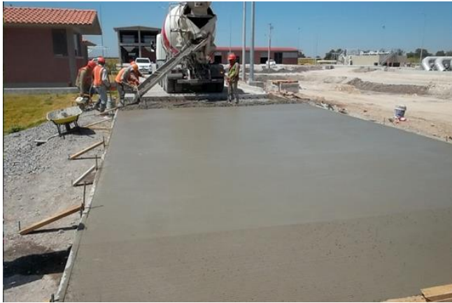
Imagen No. 78 Fabricación de firme de concreto. Fuente: Directorio de bienes raíces, 2014
