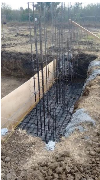
Imagen No. 66 Armado de zapata corrida. Fuente: Google, 2020
