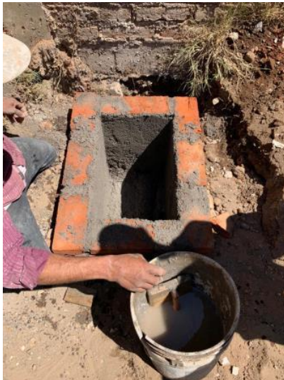
Imagen No. 72 Construcción de registro. Fuente: Google, 2018
