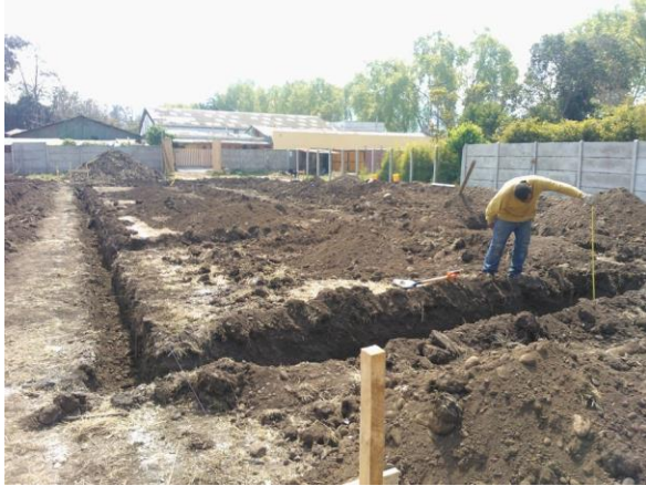
Imagen No. 65 Excavación de terreno. Fuente: Google, 2020
