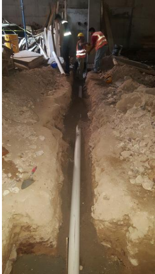
Imagen No. 73 Tendido de tubería. Fuente: Habitissimo, 2014
