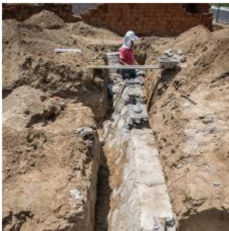
Imagen No. 67 Cimentación de mampostería. Fuente: Gramho, 2020
