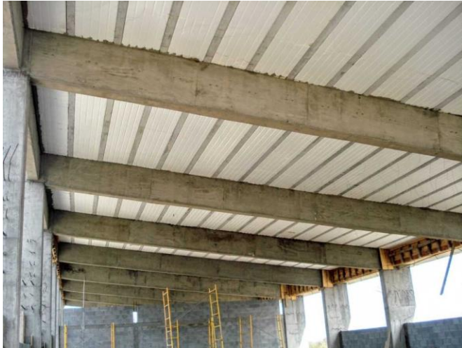
Imagen No. 79 Colocación de elemento prefabricado: losa de vigueta y bovedilla. Fuente: Velosa, 2020
