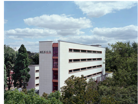
Imagen 31. Perspectiva de edificio, Residencia – Casa de Mexico. (n.d.). https://www.casademexico.org/residencia/
