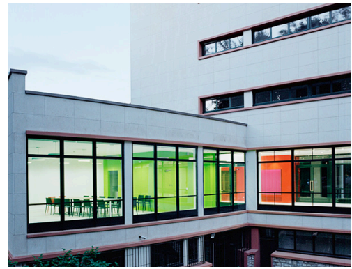
Imagen 34 Perspectiva de edificio, Residencia – Casa de Mexico. (n.d.). https://www.casademexico.org/residencia/
