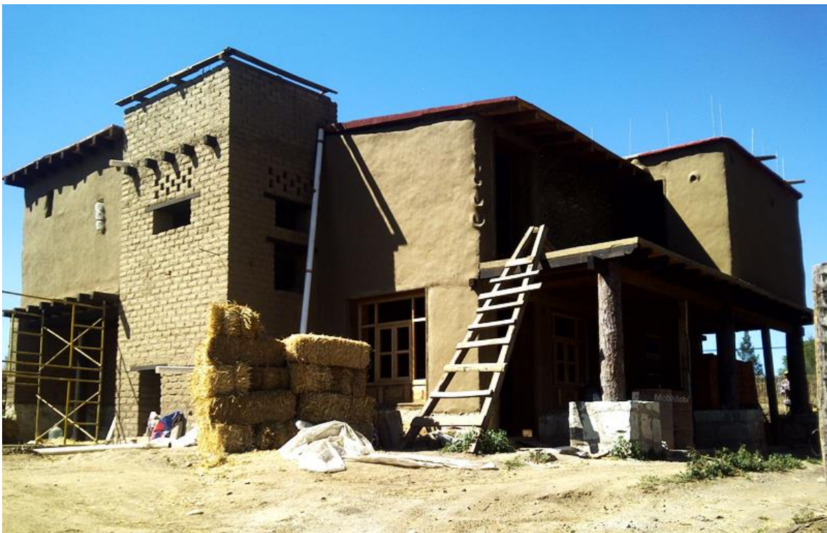
Fachada Principal de la vivienda con acabados en tierra y cal (Figura 4.5)
