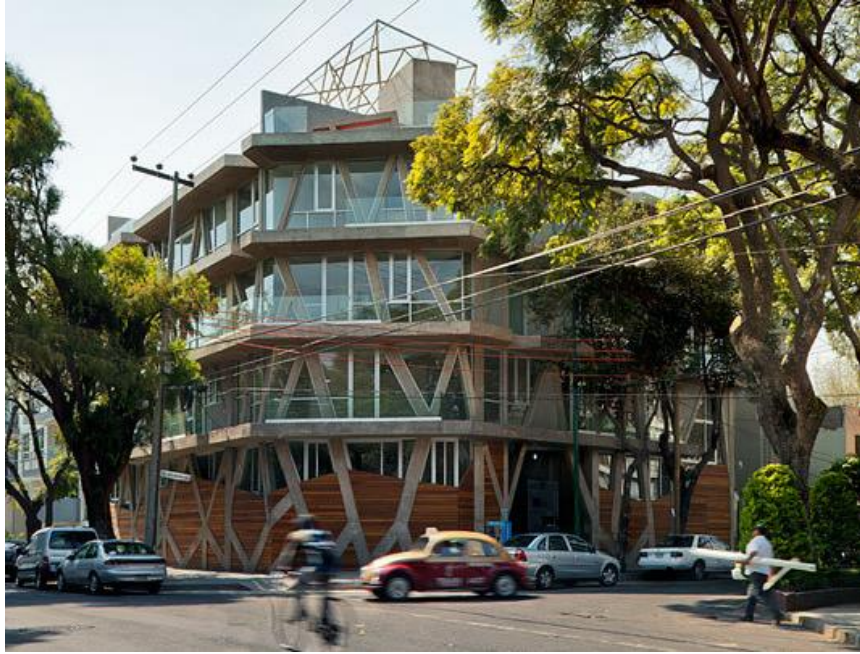
Fachada principal Nicolás san Juan (Figura 4.8) Fuente: Taller 13
