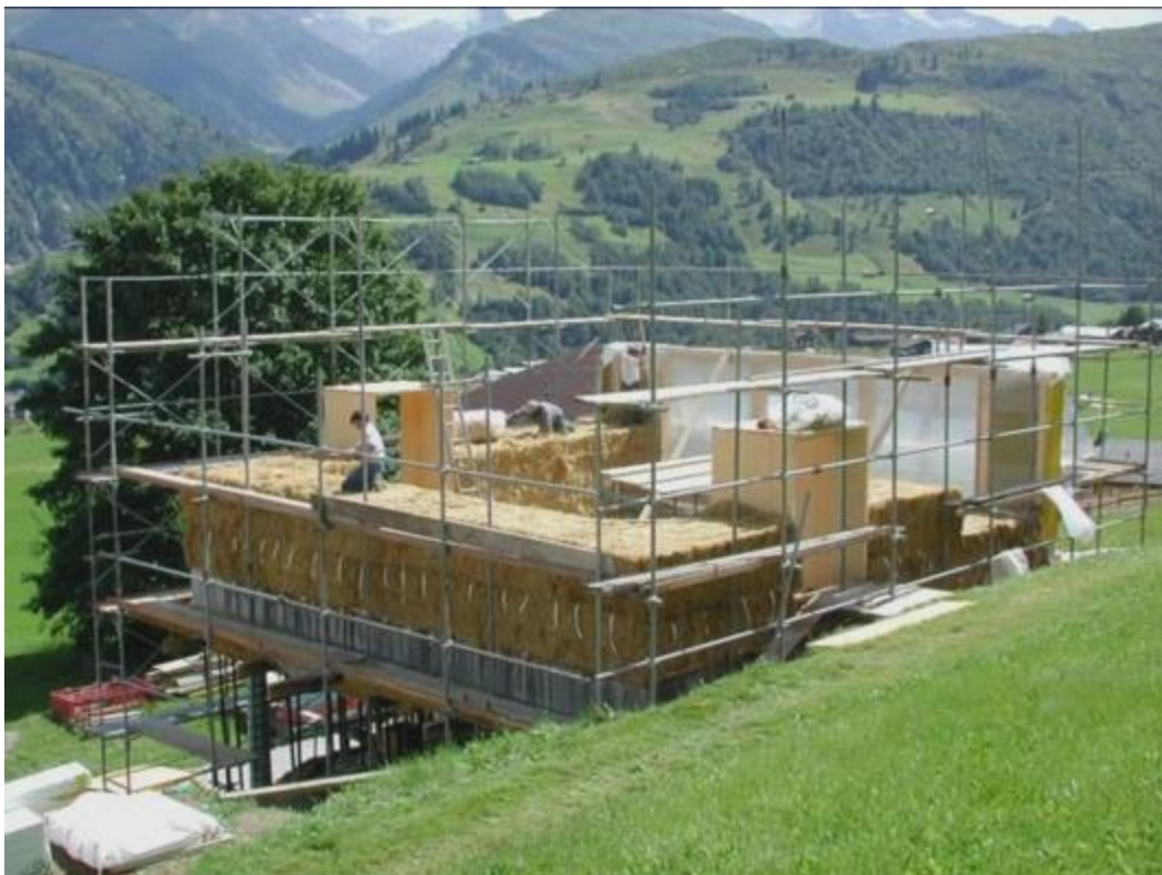
Construcción con fardos jumbo (Figura 4.24) Fuente: Werner Schmid
