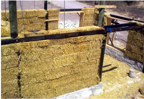
Muros de paja con marcos rígidos de madera (Figura 4.1) Fuente: eco constructores Oaxaca
