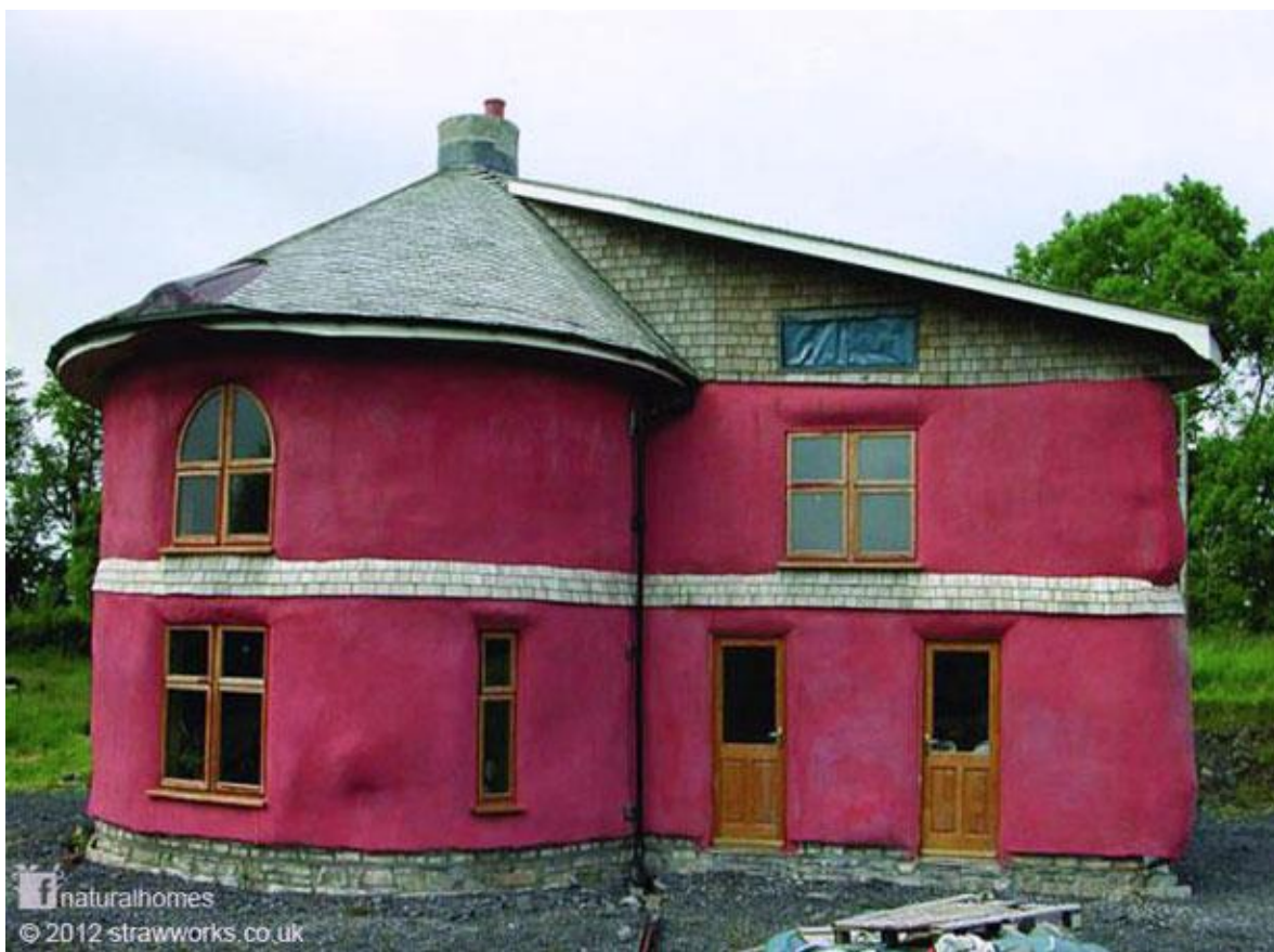
Fachada principal casa en espiral (Figura 4.25) Fuente: naturalhomes
