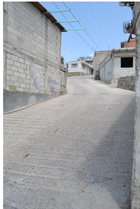
Calle pavimentada con concreto sin espacios peatonales (Imagen 2.48) Fuente: Elaboración propia
