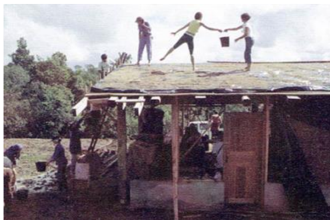
Construcción de techo verde de la vivienda (Figura 4.19)
