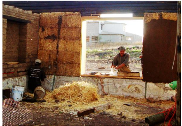
Cimentación de piedra y muros de carga de adobe (Figura 4.2) Fuente: eco constructores Oaxaca
