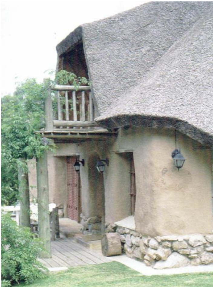
Fachada Residencia en punta ballena (Figura 4.17) Fuente: MINKE, G, & MAHLKE, F,
