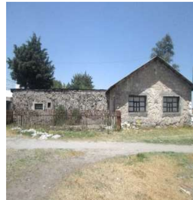
Tipología arquitectónica de la vivienda de los obreros de la antigua estación del tren de Oriental. , algunas tenían una planta de tipo L, con muros cuatropedados en forma de sillarejo y la cubierta era a dos aguas. La mayoría de las habitaciones fueron modificadas o abandonadas, dejando sólo los inmuebles como un gran recuerdo vivo parte de su historia de la población. Foto: Miguel Ángel Flores Carreto, 01/04/17, Canon.
