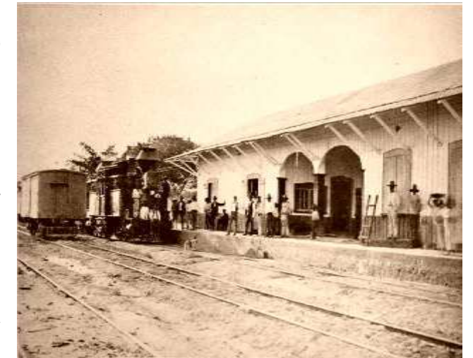
Vista de la estación, y llegada de la máquina Exa-183
