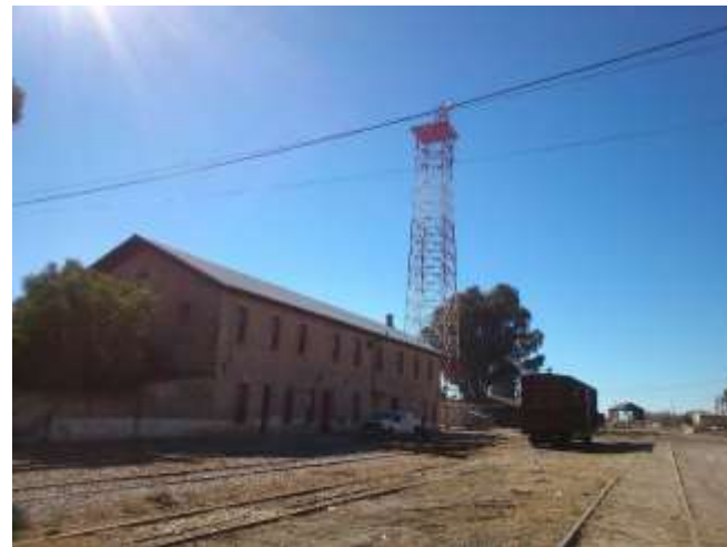
Imagen 22: Vista hacia el sur. Se muestra la parte oeste y norte de la fachada de la nueva estación del tren “Oriental”. Al fondo, se puede observar unos de los talleres que presenta grandes desgastes en su estructura. Foto: Miguel Ángel Flores Carreto 29/01/2017, Canon.
