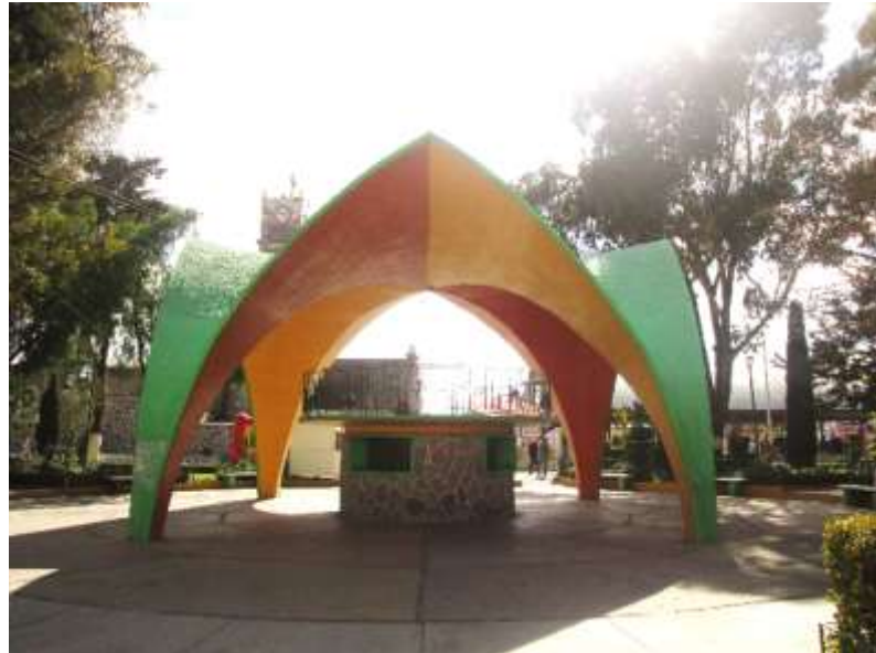
Imagen 14: Vista sobre la parte norte de la plazuela del centro, aun lado de la calle Ayuntamiento. Se muestra la estructura paraboloides con su balcón circular ligeramente peraltado. Foto: Miguel Ángel Flores Carreto 04/02/2017, Canon.
