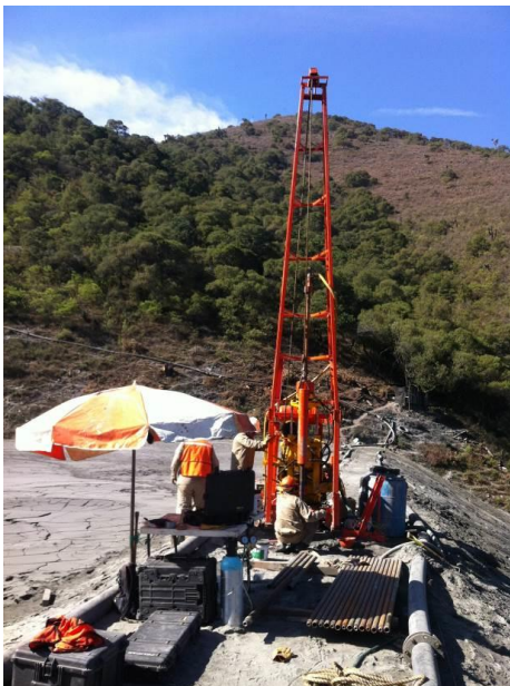
Figura 4.7. Vista general de la realización de los sondeos
