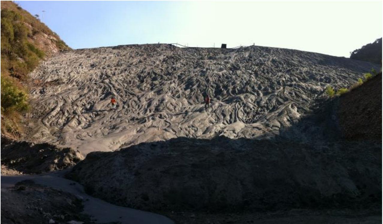
Figura 4.5. Vista panorámica de la cortina de la presa de jales
