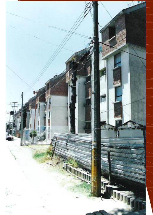
FOTO No. 41 (Arriba izquierda) VISTA SOBRE AVENIDA LAS TORRES. FOTO No. 42 (Abajo izquierda) ZONA DE RECOLECCION DE BASURA. FOTO No. 43 (Derecha) PERSPECTIVA DEL ACTUAL ESTADO DEL CONJUNTO.
