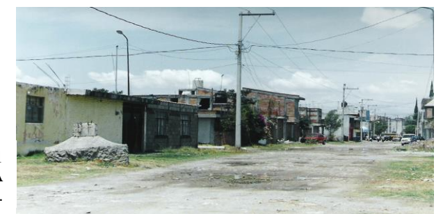
FOTO No. 61 ESTADO ACTUAL DE CALLES EN LA COLONIA TRES CRUCES.
