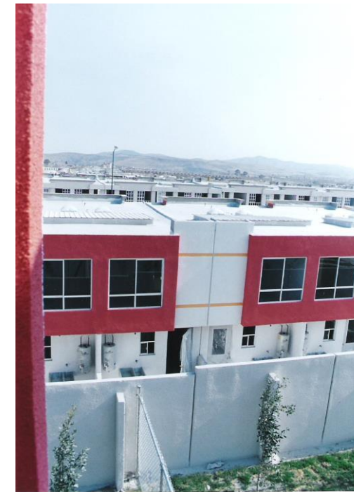
FOTO No. 58 PERSPECTIVA POSTERIOR EN UN SECTOR DE VIVIENDAS.
