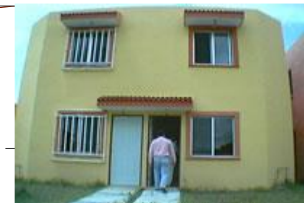
FOTO No. 29 FACHADA PRINCIPAL VIVIENDA TIPO
