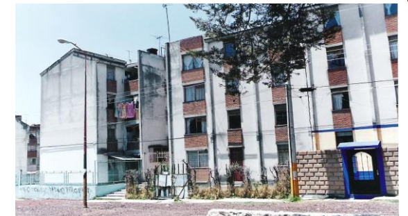
FOTO No. 46 (Arriba) AREAS DE ESTACIONAMIENTO “PRIVADAS”. FOTO No. 47 (Centro) COMERCIO INFORMAL. FOTO No. 48 (Abajo) PERSPECTIVA DEL CONJUNTO.
