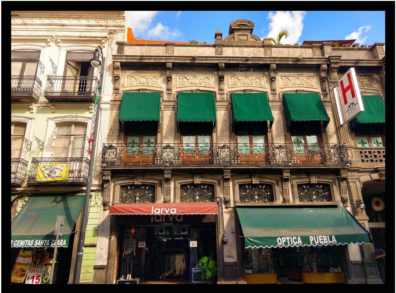
Imagen 46. En esta fotografía tomada sobre la 2 norte y avenida 6 poniente, podemos apreciar esta casona convertida en hotel. La mayoría de casonas convertidas en hoteles ubicados en el centro histórico, mantienen en buenas condiciones la arquitectura del lugar. Autora: Marina E. Hernández Jaramillo. Puebla, Pue. Junio de 2019. Fotografía tomada con un dispositivo móvil. Coordenadas: 19.045780,-98.195908
