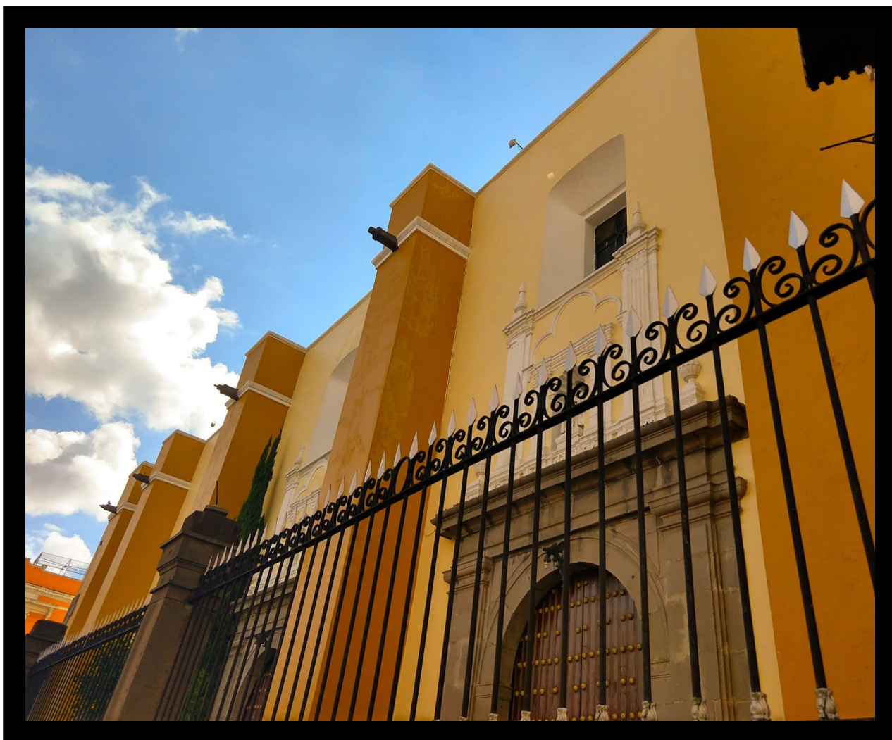
Imagen 42. Fotografía de la fachada de la iglesia de Santa Teresa de Ávila, iglesia ubicada en la calle 2 norte y avenida 8 poniente. Autora: Marina E. Hernández Jaramillo. Puebla, Pue. Junio de 2019. Fotografía tomada con un dispositivo móvil. Coordenadas:19.047007,-98.195265
