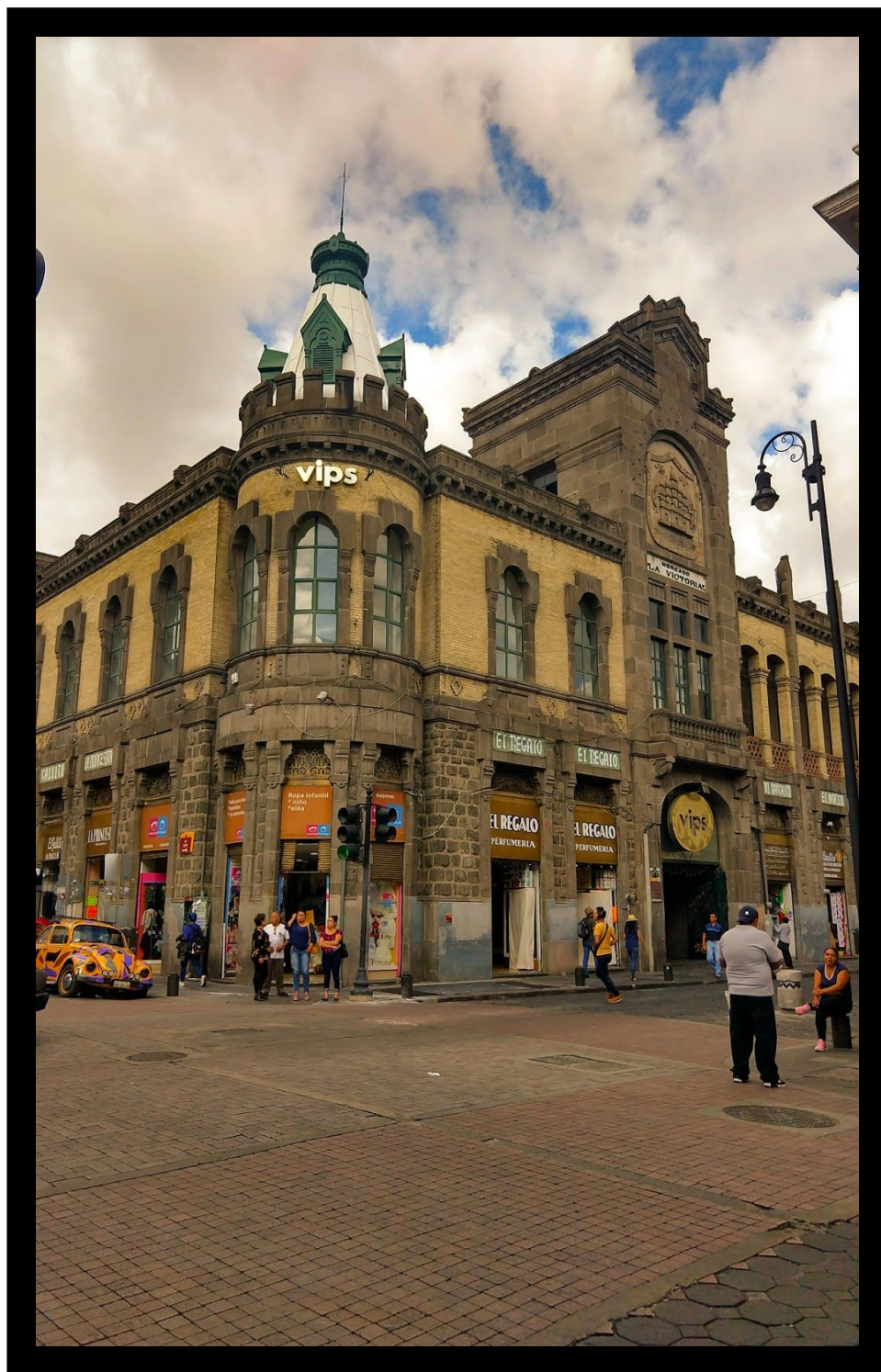
Imagen 35. Esquina de la 4 poniente y 3 norte, en esta imagen podemos apreciar la fachada actual del antiguo mercado la Victoria. Actualmente el antiguo mercado, esta lleno de restaurantes, negocios de ropa y accesorios. Autora: Marina E. Hernández Jaramillo. Puebla, Pue. Junio de 2019. Fotografía tomada con un dispositivo móvil. Coordenadas: 19.046766,-98199182
