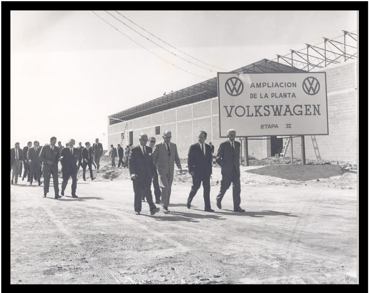
Imagen 33- Construcción de la planta automotriz Volkswagen, año 1962. Fuente: ( https://www.facebook.com/groups/puebla.antigua )
