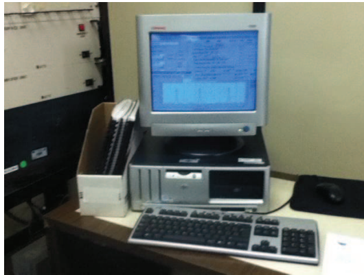
Figura 3.22. Sistema de control y adquisición.
