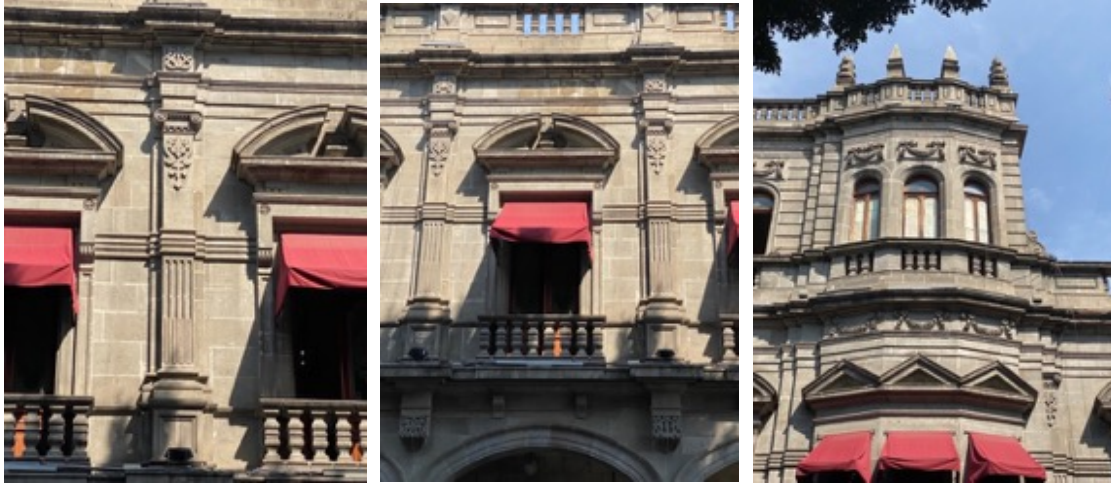
Imágenes 236, 237 y 238. Pilastras y frontones curvos y triangulares en el segundo nivel de la fachada del Palacio Municipal (Fotografías: Ana Martha H. Castillo)
