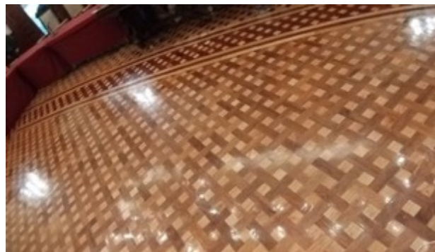
Imagen 256. Piso de parqué. Decoración interior de la Sala de Cabildo del Palacio Municipal. (Fotografía: Ana Martha H. Castillo)
