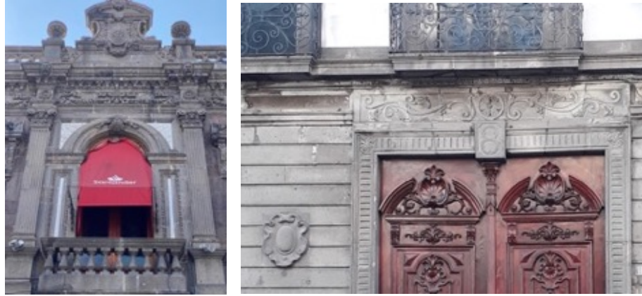
Imágenes 127 y 128. Elementos vegetales en las claves de los vanos de la fachada de las casas ubicadas en Reforma 319 y 2 poniente 108 (Fotografía: Ana Martha H. Castillo)
