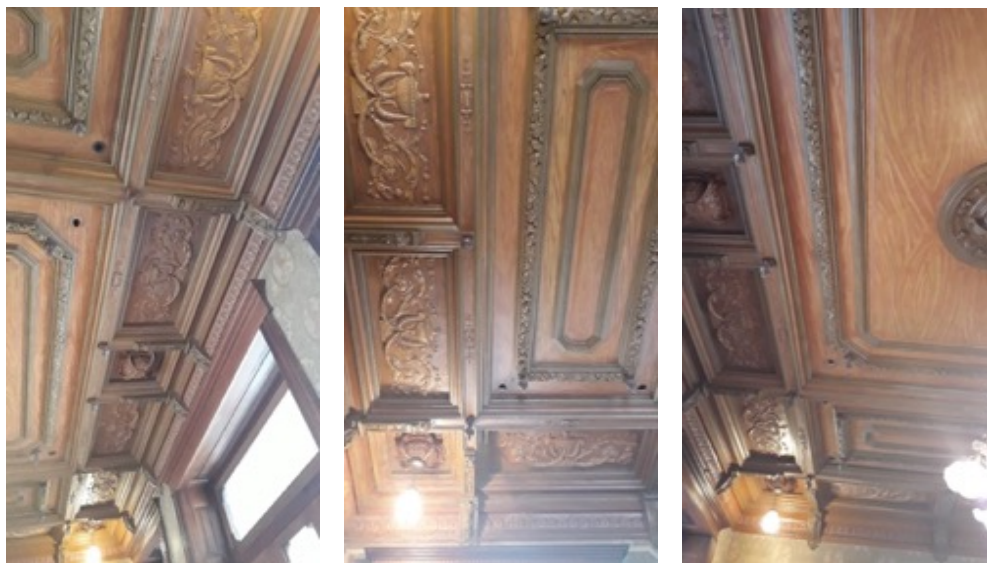
Imágenes 449, 450 y 451. Artesonados en el techo de lo que fuera el comedor de la casa ubicada en Juan de Palafox 208. (Fotografías: Ana Martha H. Castillo)
