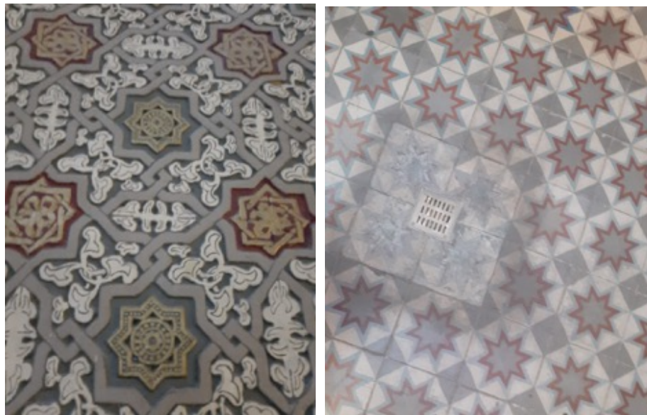
Imágenes 269 y 270. Detalle de los pisos del edificio del actual Congreso del Estado de Puebla (Fotografías: Ana Martha H. Castillo)
