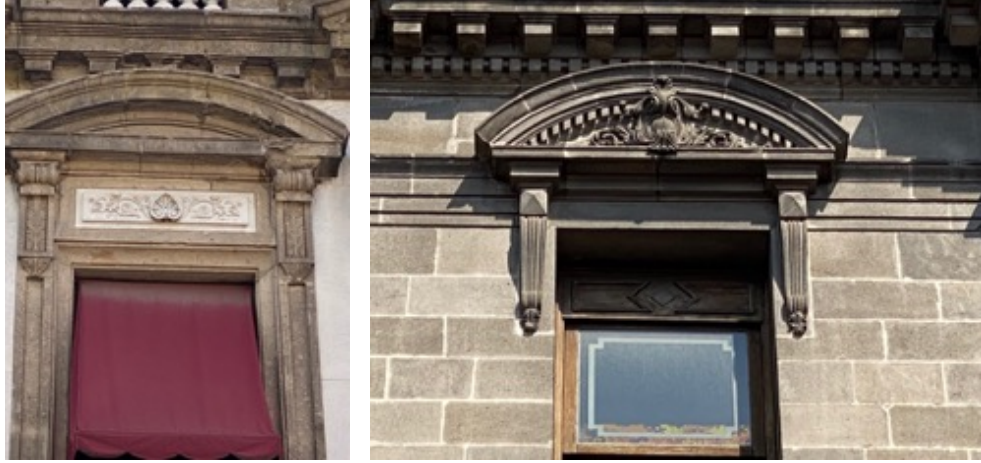
Imágenes 299 y 300. Frontones curvos sin partir en las fachadas de las casas ubicadas en Av. Reforma 113 y el Banco Oriental (Juan de Palafox y 2 norte) (Fotografías: Ana Martha H. Castillo)
