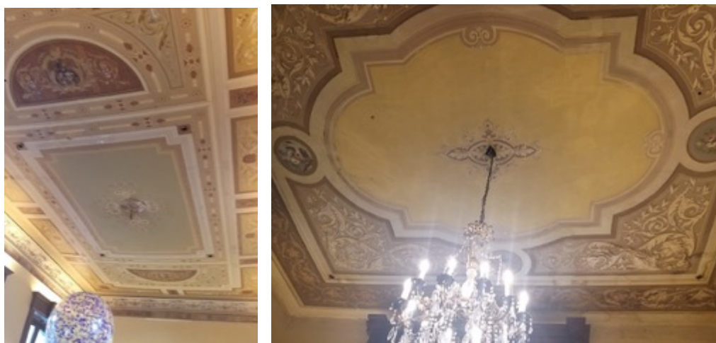
Imágenes 197 y 198. Cielos rasos al interior de la casa ubicada en Av. Reforma #538 (Fotografías: Ana Martha H. Castillo)
