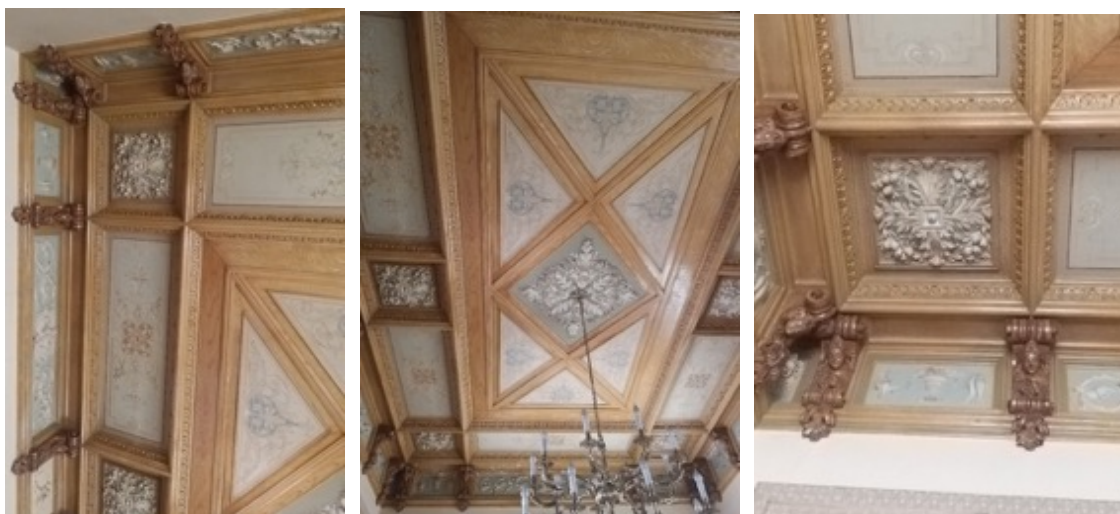
Imágenes 452, 453 y 454. Artesonados en el techo de lo que fuera el comedor de la casa ubicada en Juan de Palafox 222 (Fotografías: Ana Martha H. Castillo)
