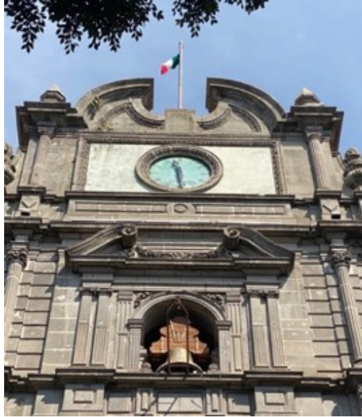
Imagen 243. Vano principal del tercer nivel de la fachada del Palacio Municipal (Fotografía: Ana Martha H. Castillo)
