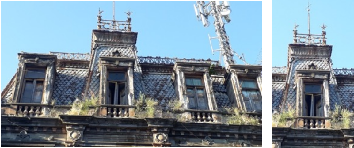
Imágenes 190 y 191. Mansarda del tercer nivel de la fachada de la casa ubicada en Av. Reforma #517 (Fotografías: Ana Martha H. Castillo)
