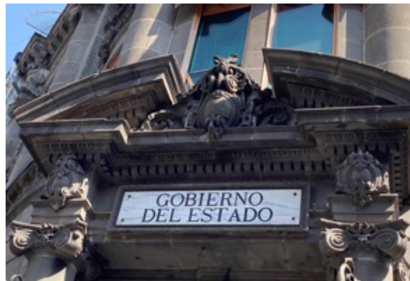
Imágenes 380 a 384. Frontones curvos partidos con decoración de medallones y elementos fitomorfos en el Salón de Cabildos del Palacio Municipal de Puebla y en las fachadas de las casas ubiadas en Reforma 515, Reforma 538, Reforma 717 y Juan de Palafox y 2 norte (Fotografías: Ana Martha H. Castillo)
