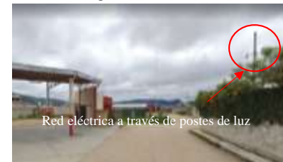
Imagen 13: Poste de luz que abastece al terreno. Google Maps (2022).
