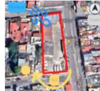
Imagen 23: Variable ambiental en estación de bomberos S.C.L.C. Google Maps (2022).
