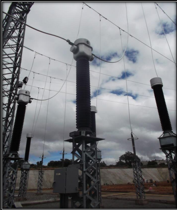
Ilustración 12, Transformador de corriente (Tc's) 15 en bahías de 230kv
