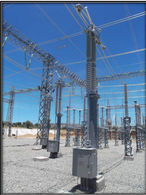
Ilustración 7, Cuchillas tipo pantógrafo 18 grupos 3 \phi en bahías de 230kv
