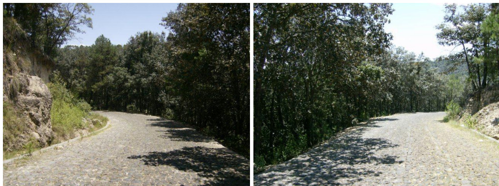
(Fotografías 3 y 4) Tramo de 1 Km. De empedrado hacia el acceso Del predio
