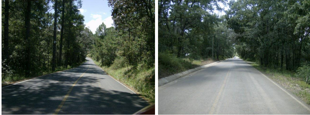
(Fotografías 1 y 2) Tramo de 8 km. De carretera asfaltada hacia la Comunidad de Ixtula y Zembo.
