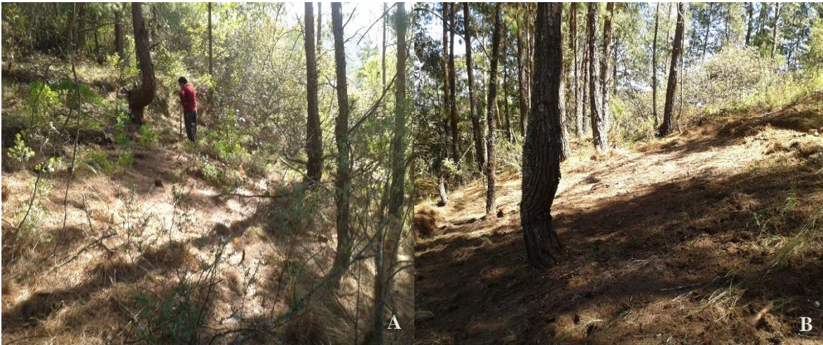
Figura 6. Delimitación (A) y limpieza del terreno (B).
