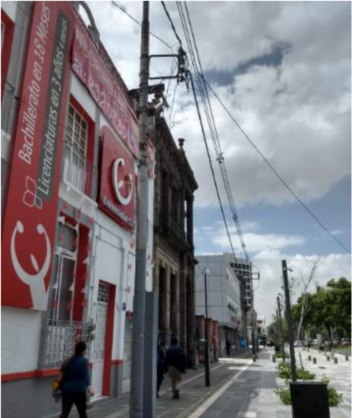
Figura 3. 10 Líneas de M.T. existentes entre Av. Juárez y 11 Poniente.
