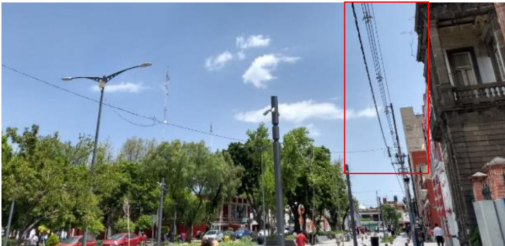
Figura 3. 13 Conductor AAC 266 con separadores Hendrix.
