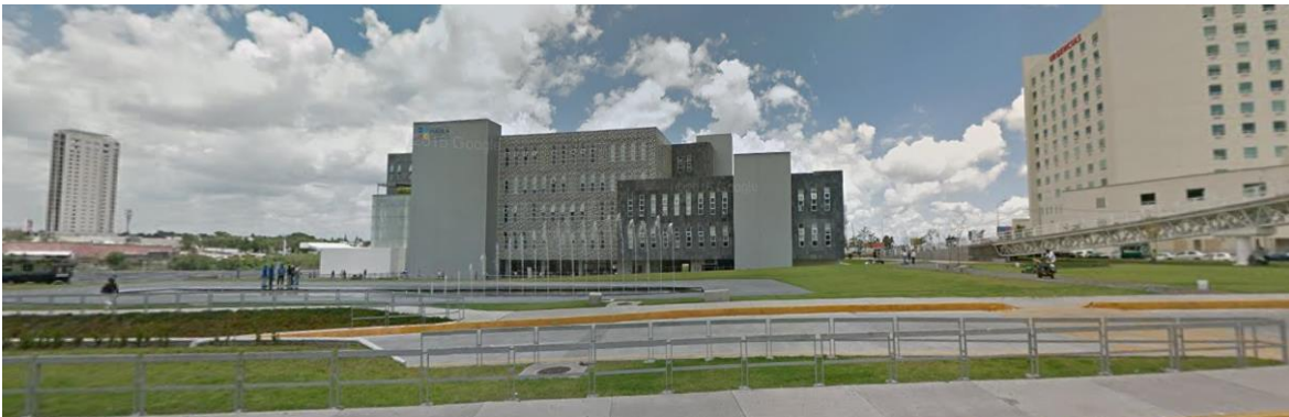
Figura 2. 1 Centro Integral y de Servicios edificio sur.
