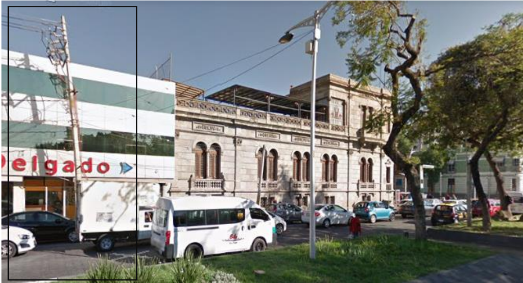
Figura 1. 4 Instalaciones aéreas existentes a unos metros del conservatorio
