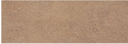
Textura de un muro de adobe
