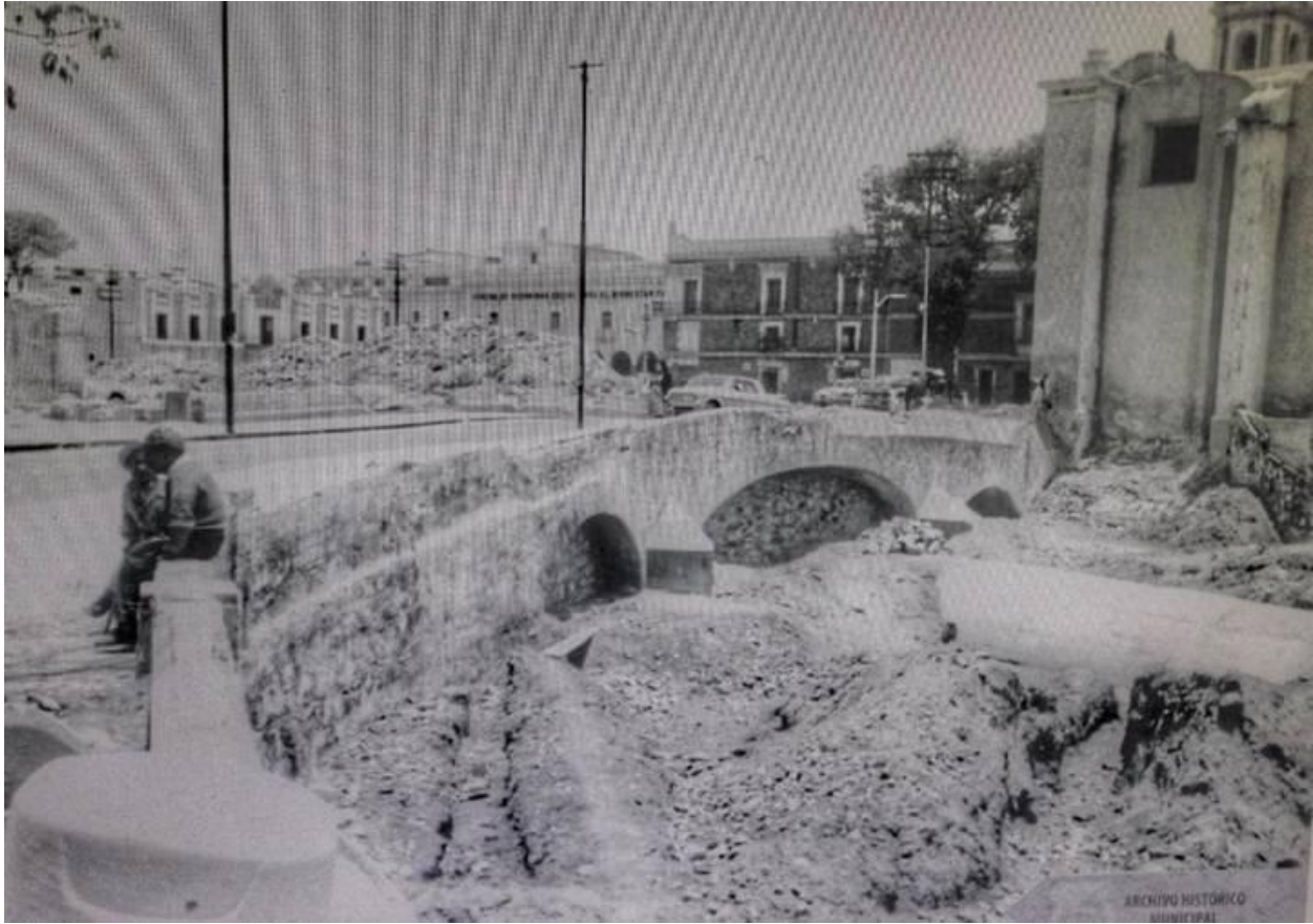
Figura 3. Iglesia de Dolores durante los trabajos de entubamiento del Río San Francisco. Nota: Se pueden apreciar claramente los trabajos de entubamiento antes de la desaparición del puente. (Reyes, 2021)
