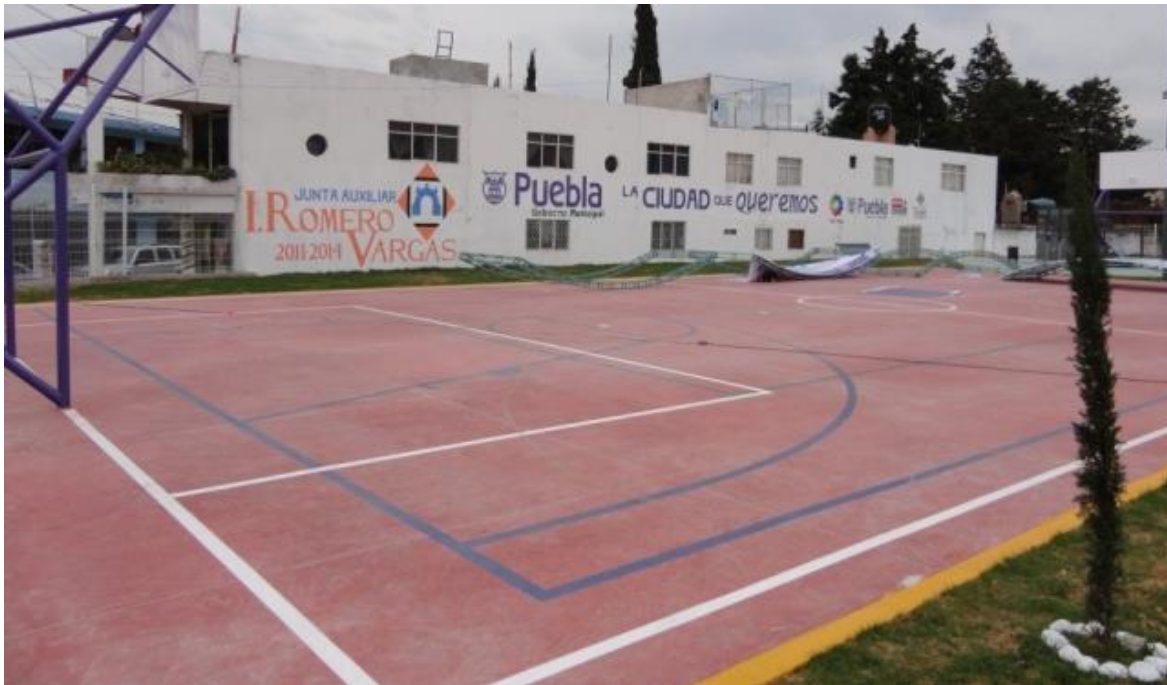
Imagen 13. Vista general de cancha de usos múltiples.
