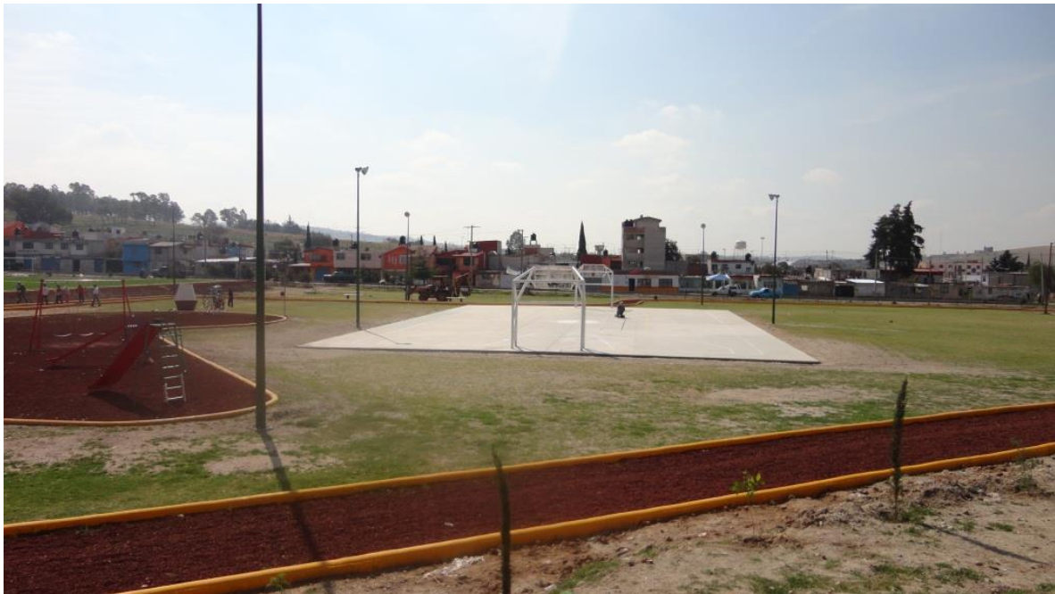
Imagen 11. Vista general de cancha de usos múltiples, juegos infantiles y trota pista.
