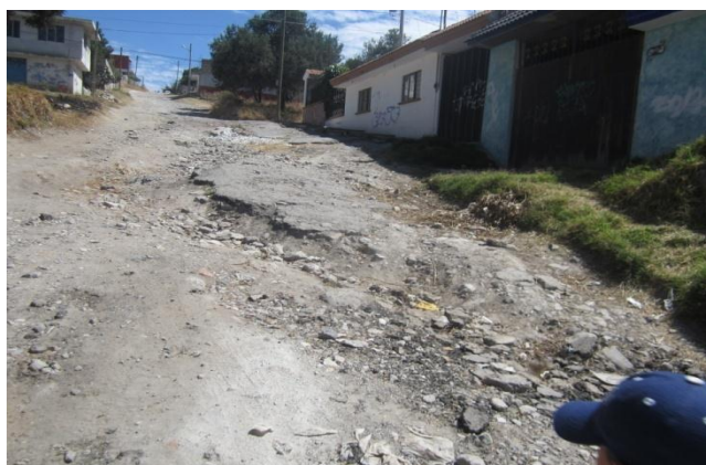
Foto: Vista de la Calle Agustín Arrieta y Fernando Arruti (Rivera, 2012)
