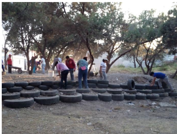
Foto: Construcción de talud con llantas (Rivera, 2014)
