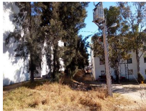
Fotografía 30 Acciones aisladas de mantenimiento. Valencia, febrero 2017.
