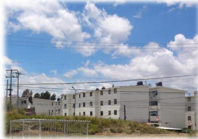
Fotografía 6. Un bloque con dos edificios, al centro están unidos por la escalera en común. Fuente: Valencia, agosto, 2016
