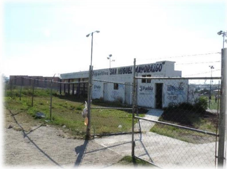
Fotografía 13. Unidad Deportiva de San Miguel Mayorazgo oficinas sin puertas, basura, reja dañada. Fuente: Tzoni, agosto 2015.
