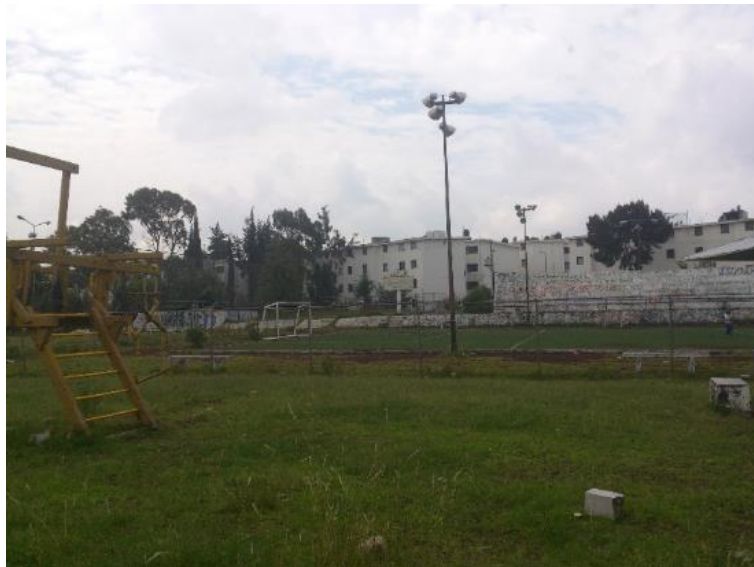
Fotografía 14. Pasto sintético dañado, juegos infantiles deteriorados, reja rota. Fuente: Tzoni, agosto 2015
