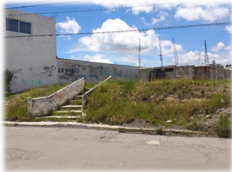
Fotografía 12. Se observa las paredes de la capilla, las escaleras y la vegetación crecida que dan el aspecto de abandonada. Fuente: Valencia, septiembre 2016.
