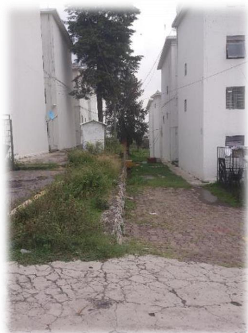
Fotografía 9. Andadores en desnivel.
