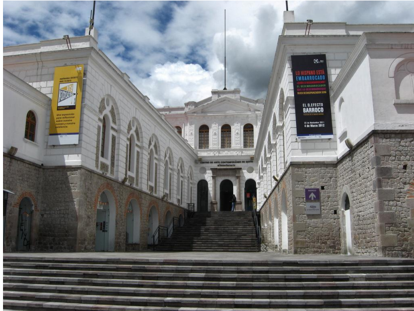
Fachada del Centro de Arte Contemporáneo de la ciudad de Quito, antiguo hospital militar Inicios de siglo XX http://www.skyscrapercity.com/showthread.php?t=260699&page=18
