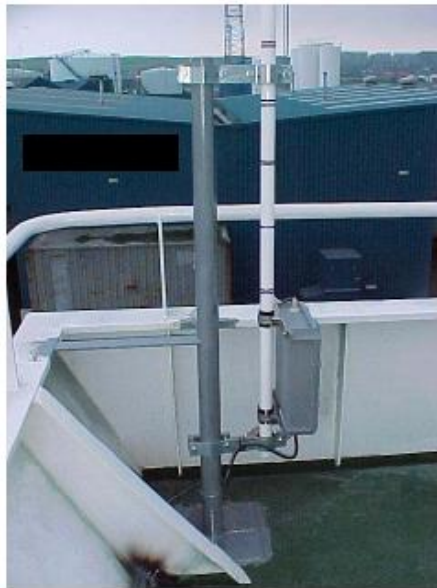
Fig. 4.4 Modo correcto de las abrazaderas
