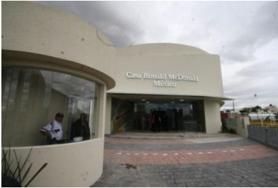
Imagen 13. Fachada de albergue fundación Ronald
