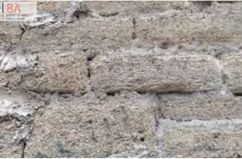
Imagen 3.5.12 Muro de adobe Fuente: Archivo fotográfico propio
