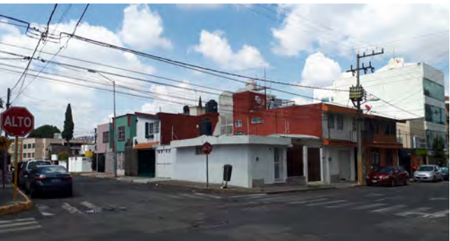
Infraestructura de calles del Barrio de Analco. Fuente: Archivo fotográfico propio.
