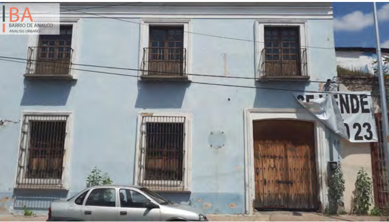
Imagen 3.5.13 Fachada de inmueble ubicado en la 9 Oriente. Fuente: Archivo fotográfico
