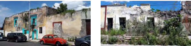
Viviendas/vecindades abandonadas ubicadas en el Barrio de Analco
