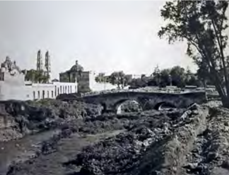
Imagen 3.5.3 Fotografía del río San Francisco a la altura del puente de Ovando (3 ote.). Fuente: https://twitter.com/pueblaantigua/status/494824792432705536 .
