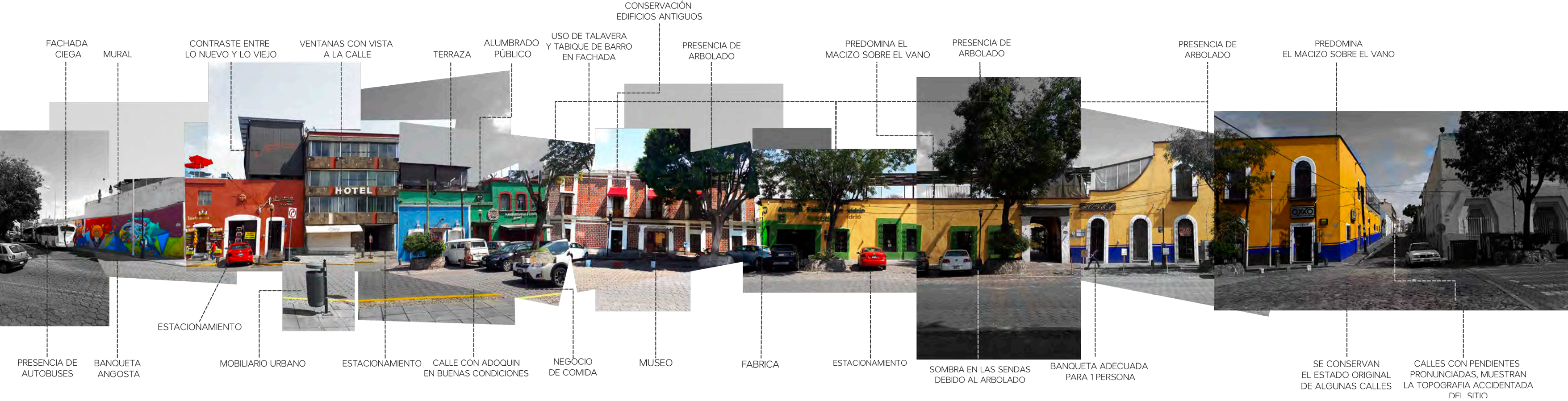
Imagen 2.7 Levantamiento fotográfico calle 3 oriente
