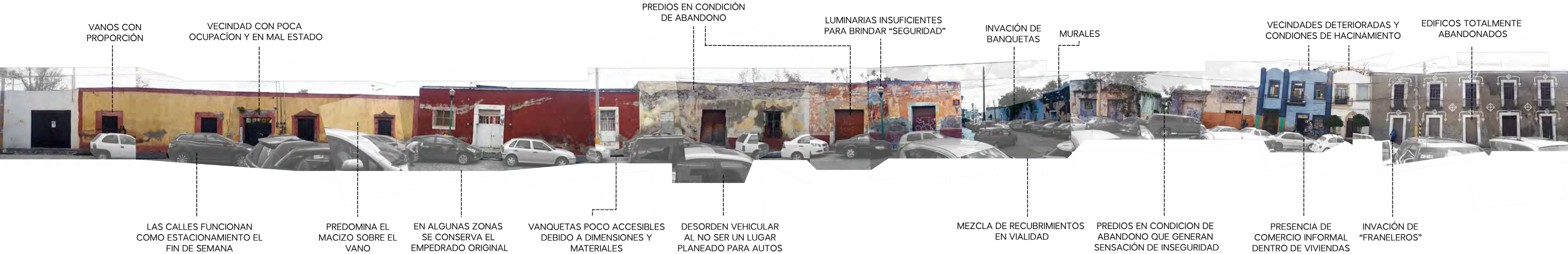
Imagen 2.6 Levantamiento fotográfico calle 7 oriente
