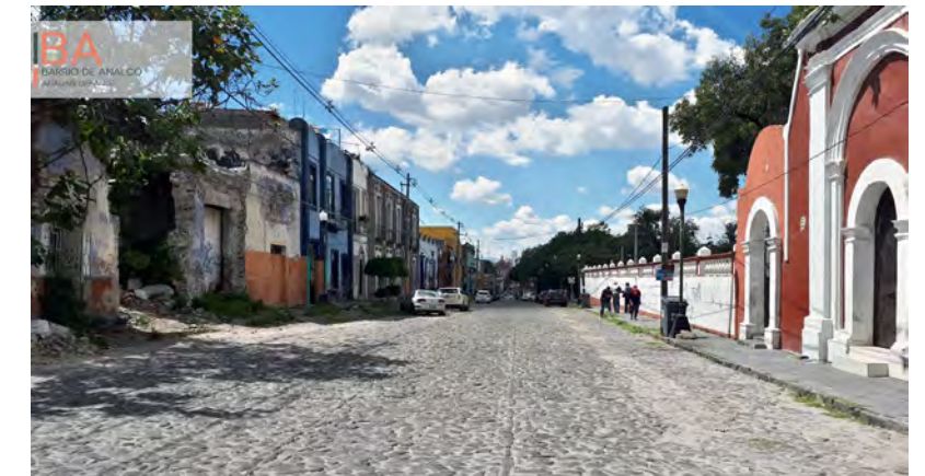
Fotografía 2.1. Calle 7 oriente, estado actual. Fuente: Archivo fotográfico propio.
