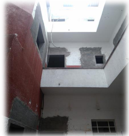
Foto 22. Vista de los departamentos desde la planta baja (Hernández, 2017)
