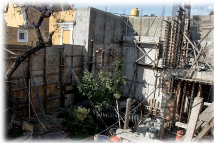
Imagen 13. Interior de la Casa del Torno, se aprecia que los muros interiores originales fueron demolidos para la edificación de una torre no del teleférico no construida (Martínez, 2016)
