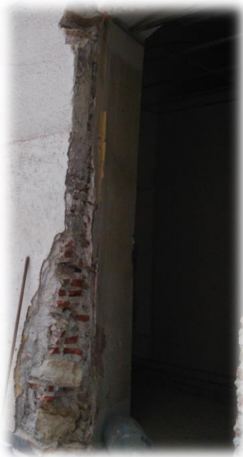
Foto 15. Detalle de los ladrillos en uno de los muros (Hernández, 2017)
