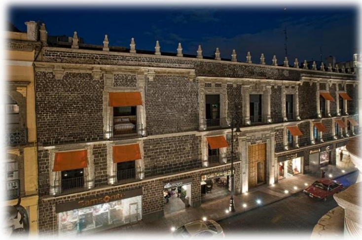
Imagen 36. Fachada principal (Booking, Hotel Downtown en la CDMX, s.f.)
