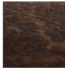
(VG-2) Viga de madera restaurada y tratada, acabado original
