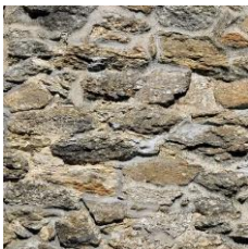
(R) Muro original, acabado rustico, materiales originales expuestos
