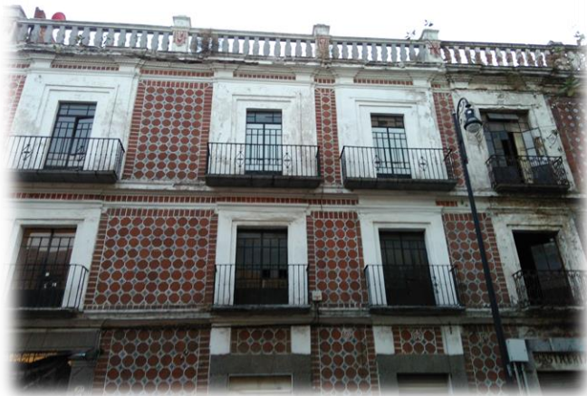
Foto 14. En la fachada del inmueble se aprecian los elementos de ladrillo, yeso y cantera; distintivos de la época barroca (Hernández, 2017).
