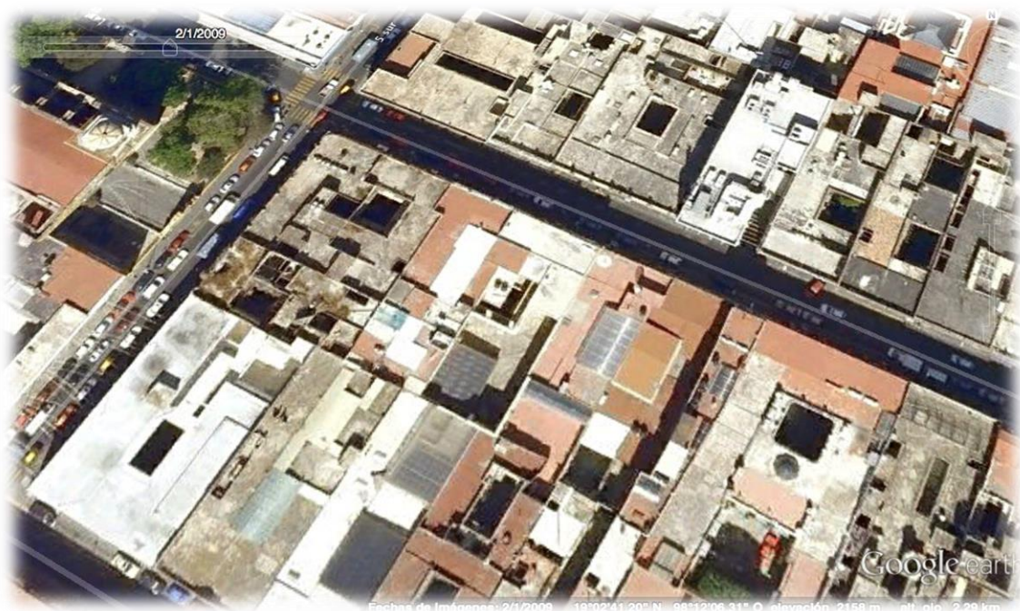
Imagen 15. Vista aérea del edificio, se pueden apreciar los patios centrales, así como las partes en las que fue fraccionada (Google).
