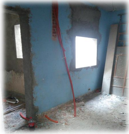
Foto 21. Ventana e instalación eléctrica (Hernández, 2017)
