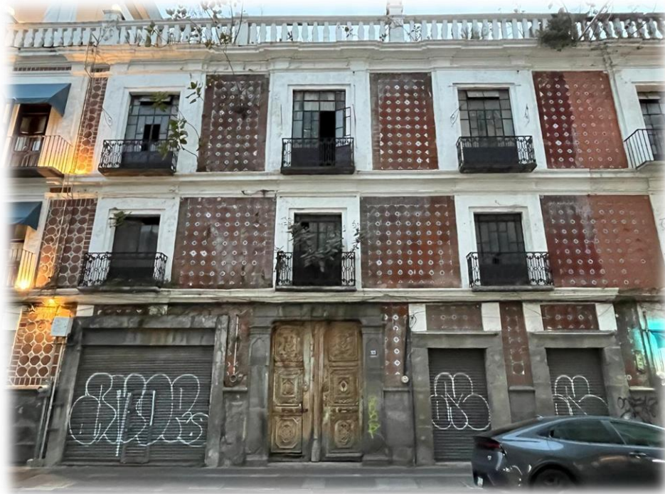
Foto 1. Edificio ubicado en la calle 3 poniente 309. Fotografía por Josué Hernández. Febrero 2025
