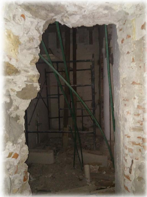
Foto 31. La mayoría de los muros originales son gruesos y no presentan algún problema estructural (Hernández, 2017).
