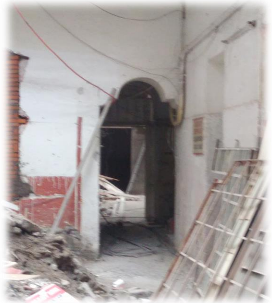
Foto 6. Pasillo que conecta con el patio trasero (Hernández, 2017)
