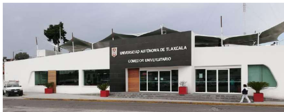
Fotografía 4. Fachada principal del comedor universitario de la UAT.
