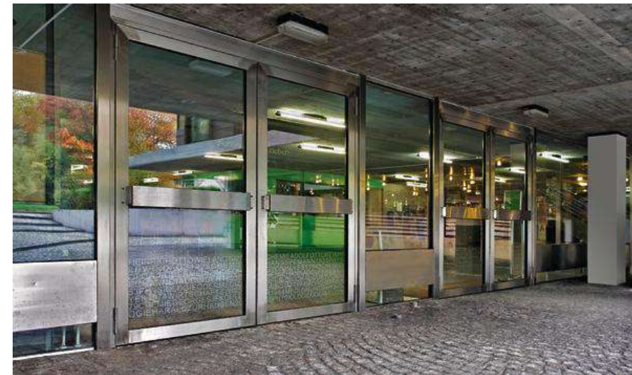
Fotografía 11. Acceso al comedor “Institusviertel”, universidad Alberto-Ludoviciana en Finburgo de Brisgovia
