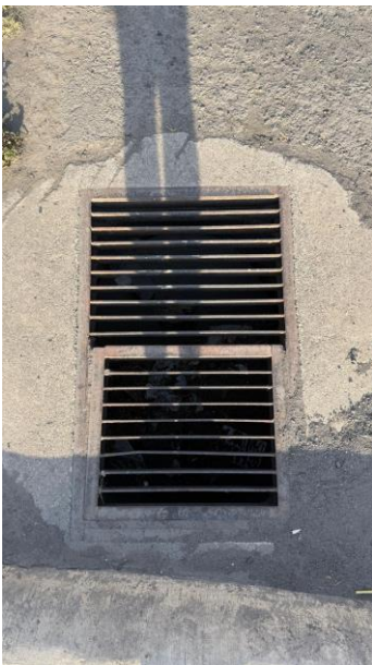
Figura 29. Rejillas para agua pluvial en Prolongación 14 sur
