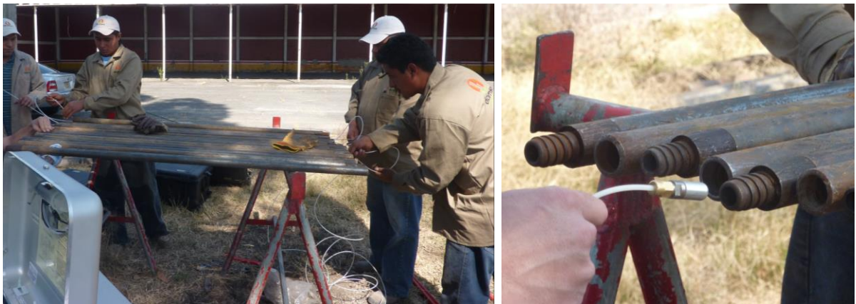
Figura 2.2.4. Vista de instalación del cable en las barras de perforación
