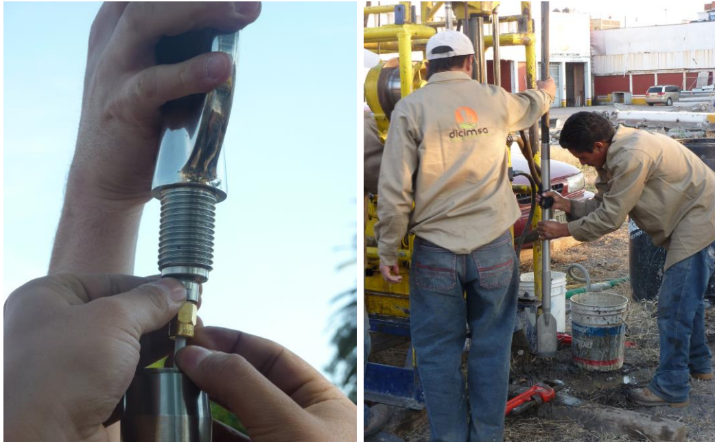
Figura 2.2.5. Vista del ensamble de la paleta del dilatómetro a las barras de perforación
