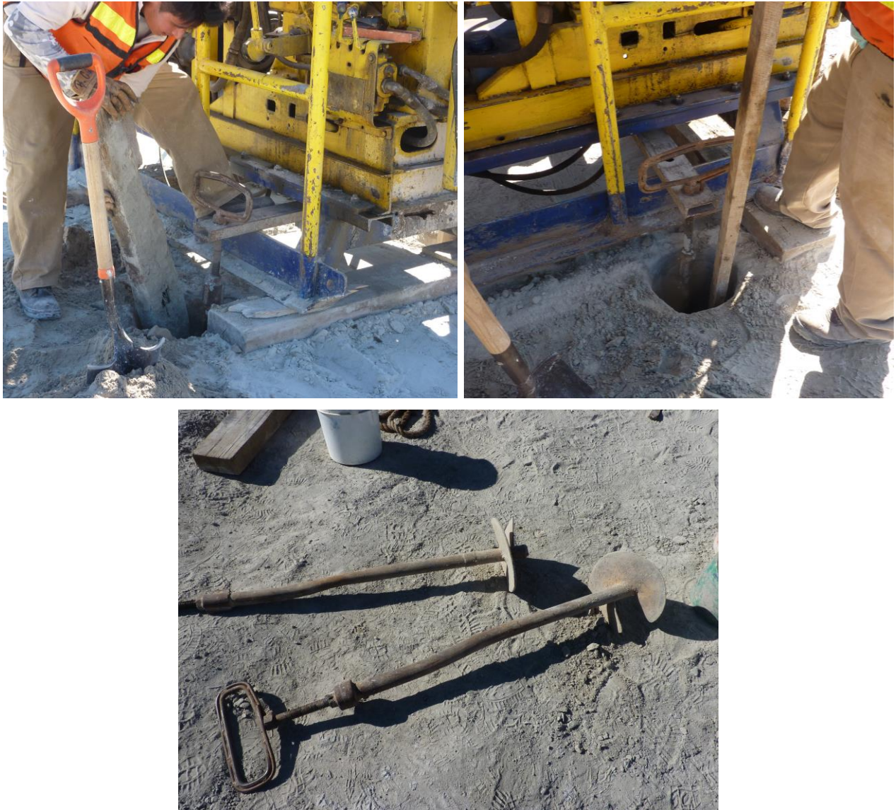
Figura 2.2.3. Vista del anclaje del equipo de perforación al suelo
