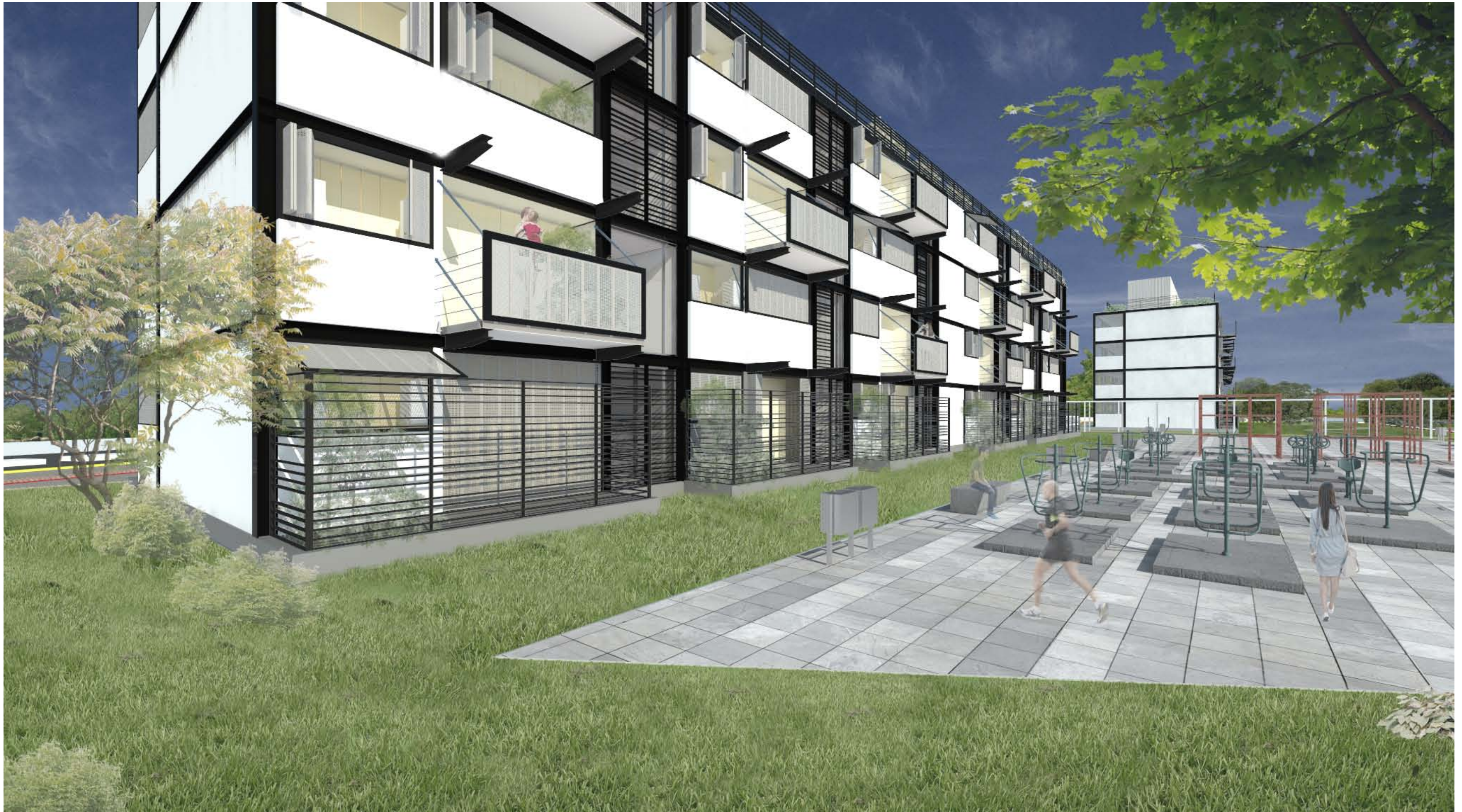
Vista exterior de uno de los edificios. Enfrente de él vemos el área de recreación con gimnasio al aire libre y juegos infantiles. Se observa las diferencias de las viviendas obtenidas por medio de los elementos dúctiles como el balcón abatible, las contraventanas y las ventilas.
