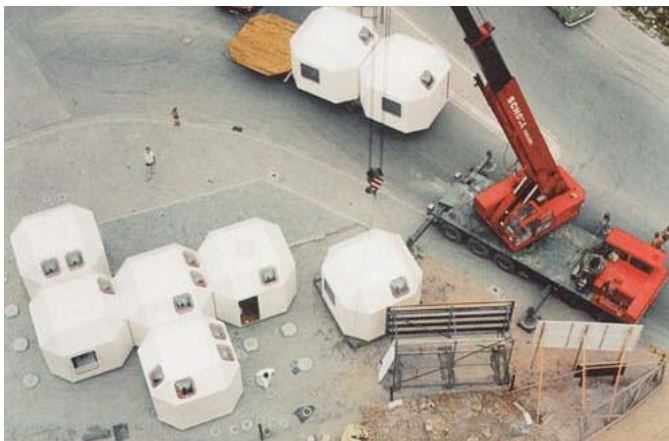
Figura 21. Módulos fabricados por Hübner+Huster. Fuente https://es.pinterest.com/pin/112027109453323294/
