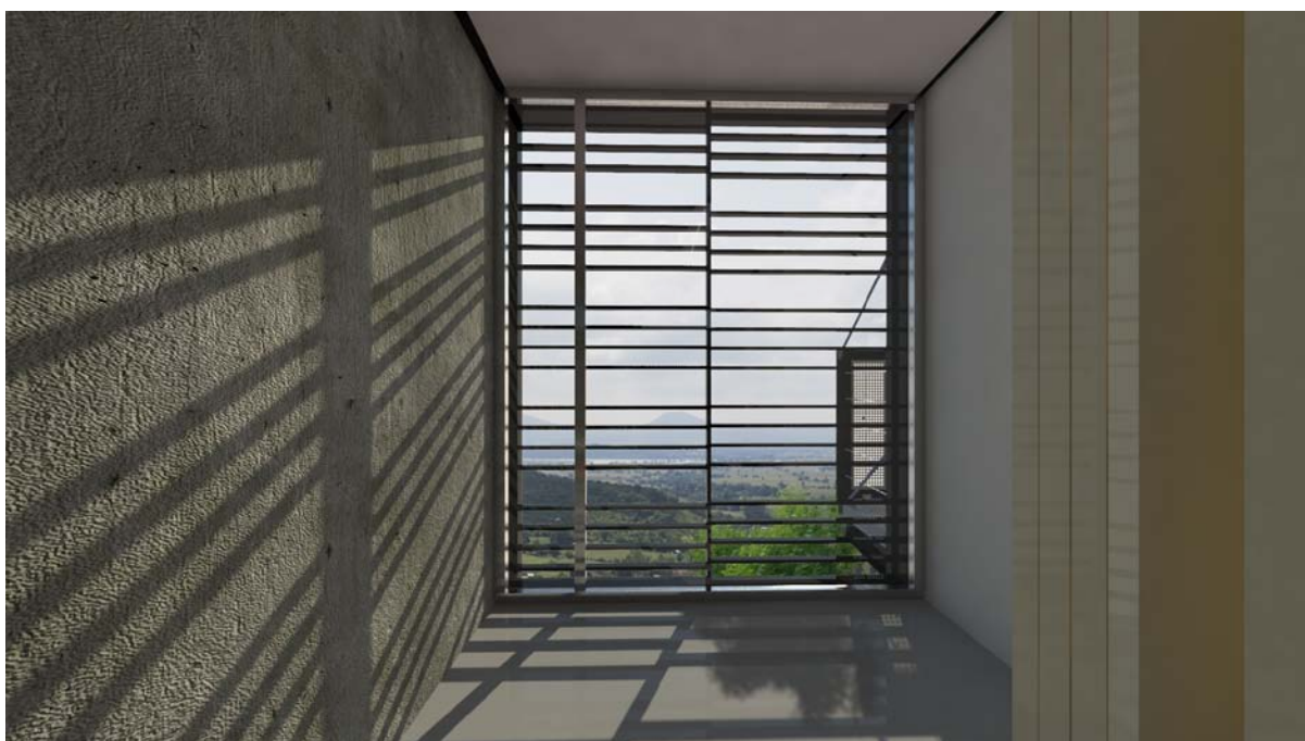
Vista hacia las áreas verdes y el paisaje de San José Chiapa desde el área de ampliación. Se observa el vano de piso a techo con cancelería de aluminio cromado y la herrería de seguridad igual de aluminio con acabado mate.
