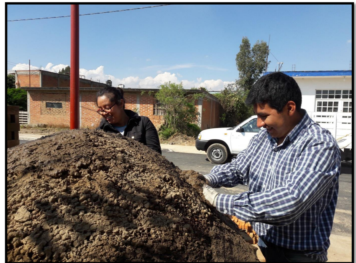
IMAGEN 5.3.15. SELLADO DE CÚPULA CON LODO. (COLECCIÓN PROPIA, 2016)
