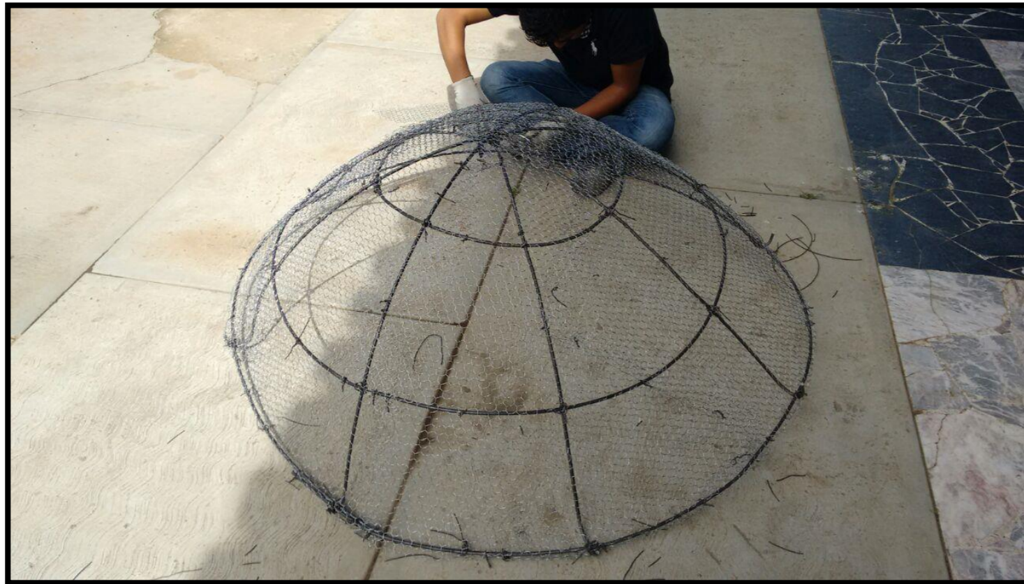
IMAGEN 5.2.7. HABILITADO DE ACERO PARA CÚPULA. (COLECCIÓN PROPIA, 2016)
