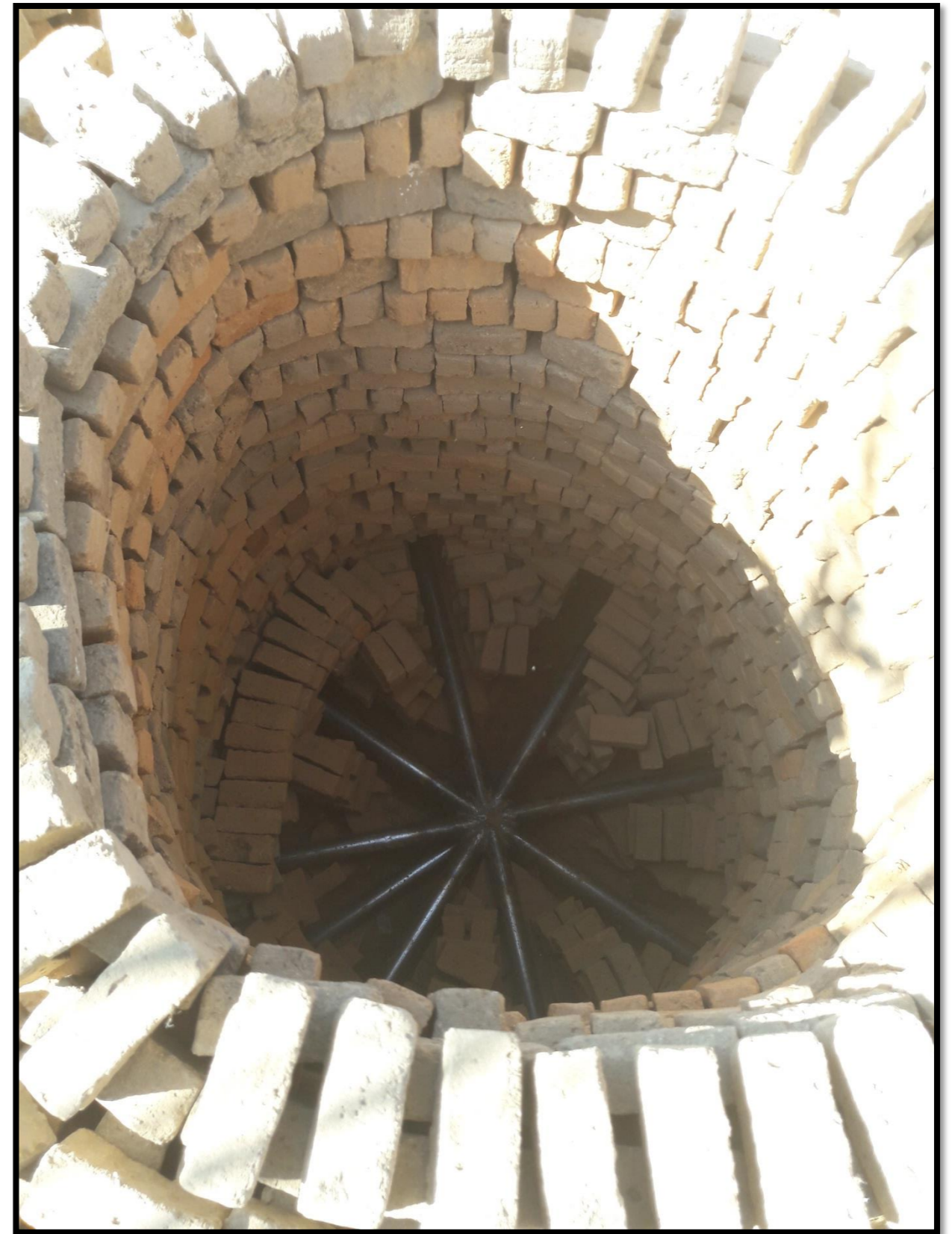
IMAGEN 5.3.9. INSTALACIÓN DE GAS. (COLECCIÓN PROPIA, 2016)
