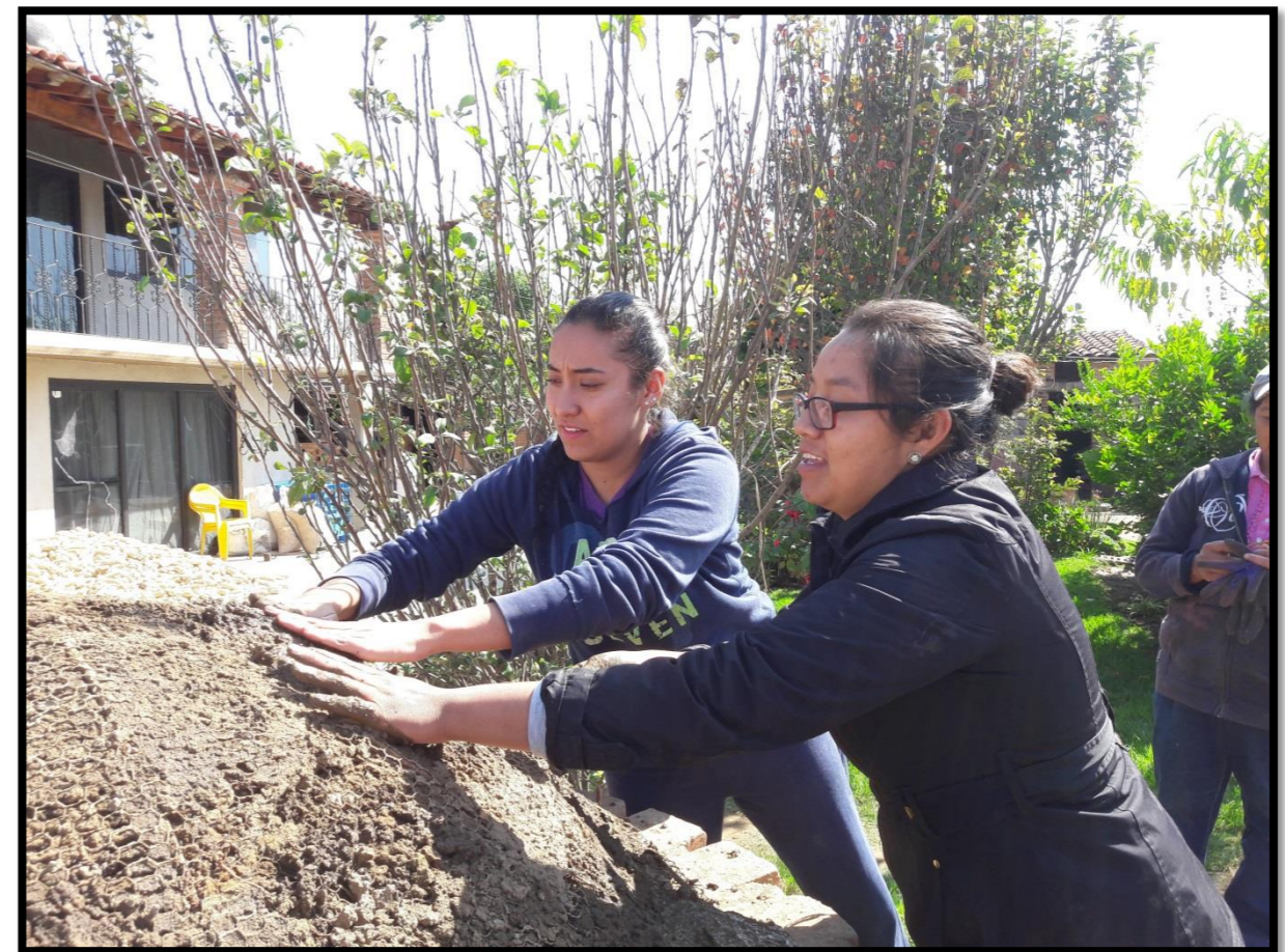
IMAGEN 5.3.14. RECUBRIMIENTO DE CÚPULA. (COLECCIÓN PROPIA, 2016)
