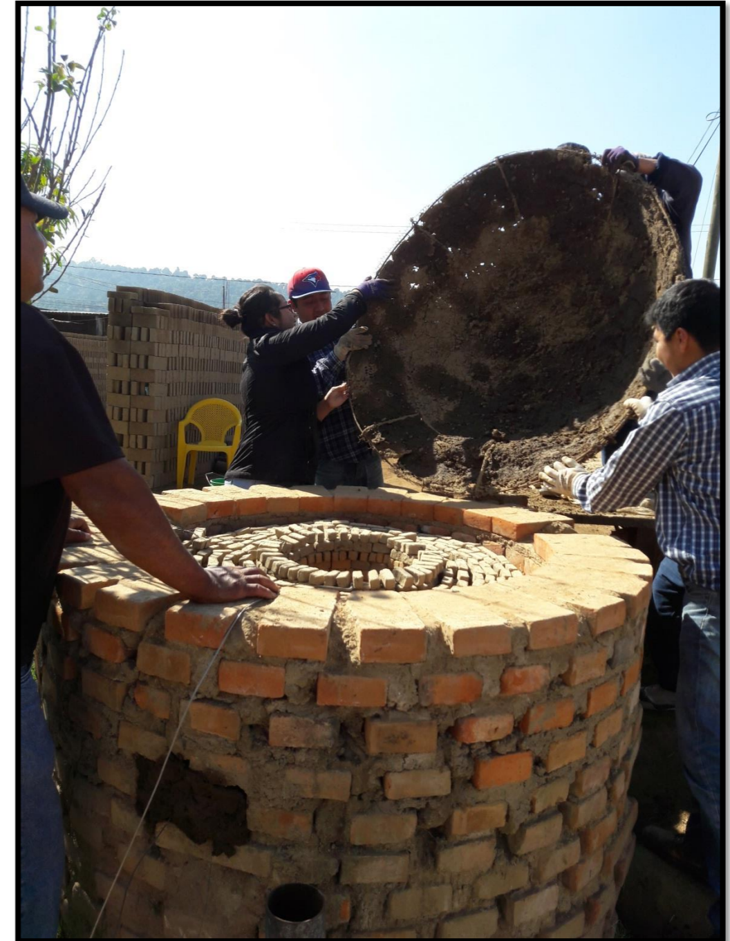
IMAGEN 5.3.22. COLOCACIÓN DE CÚPULA. (COLECCIÓN PROPIA, 2016)
