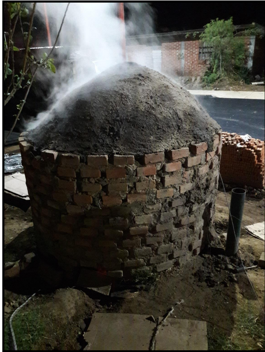
IMAGEN 5.3.23. HORNO EN FUNCIONAMIENTO. (COLECCIÓN PROPIA, 2016)
