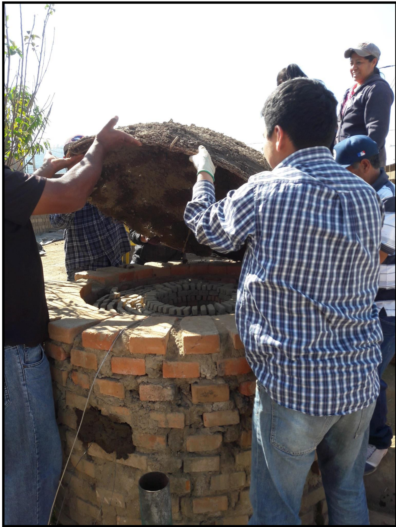
IMAGEN 5.3.13. COLOCACIÓN DE CÚPULA. (COLECCIÓN PROPIA, 2016)
