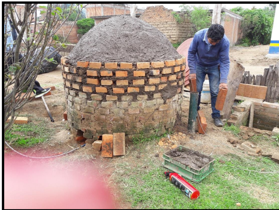
IMAGEN 5.2.28. BLOQUEO DE CORRIENTE DE AIRE. (COLECCIÓN PROPIA, 2016)
