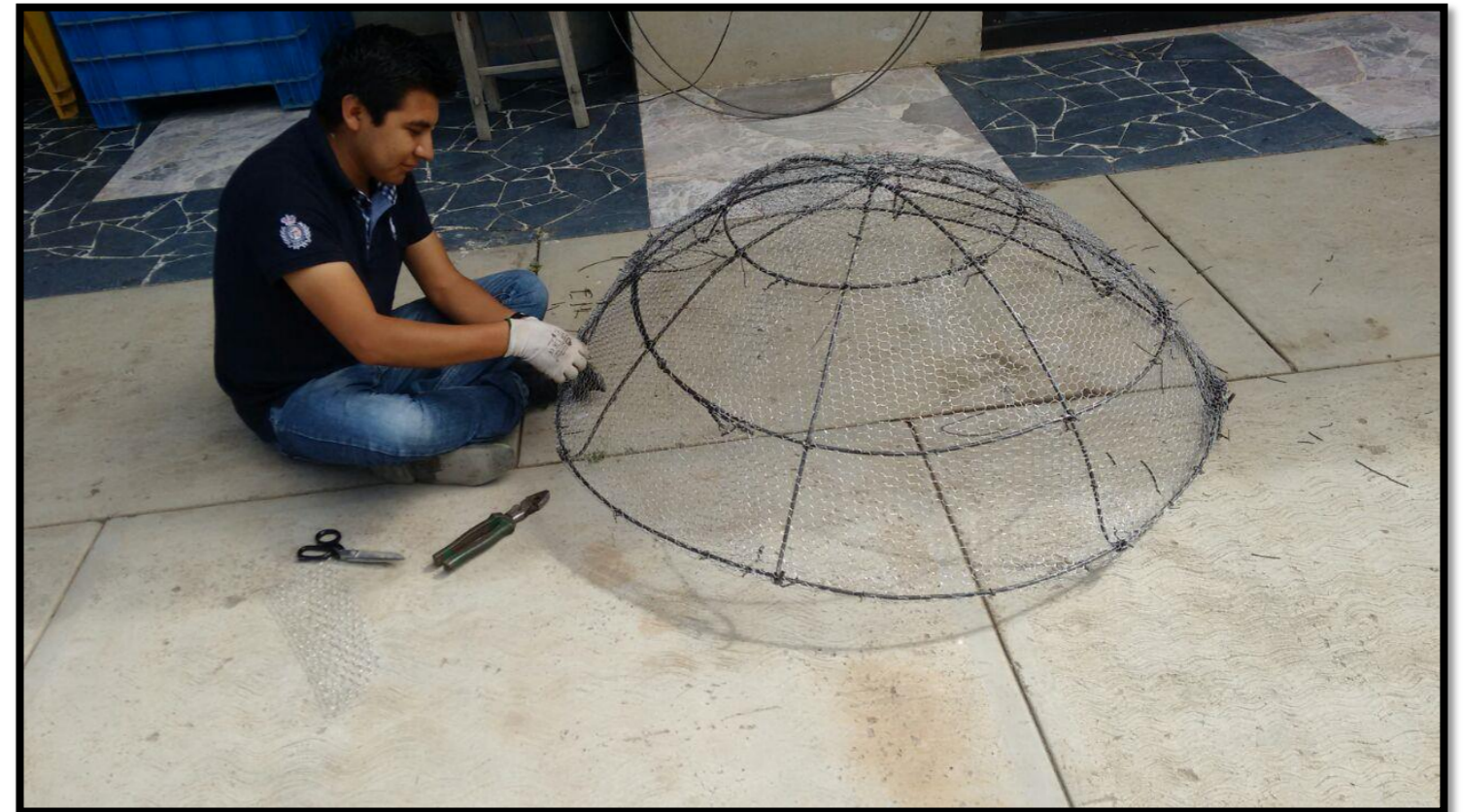
IMAGEN 5.2.8. CONSTRUCCIÓN DE CÚPULA. (COLECCIÓN PROPIA, 2016)
