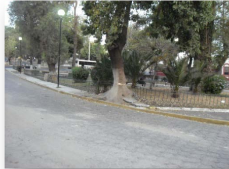
Imagen 42. Vista de vegetación y fractura de vialidad peatonal con raíces. Zona 2
