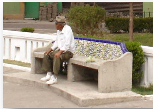
Imagen 161. Vista de mobiliario de descanso deteriorado y ubicado en zona 4 del Parque.
