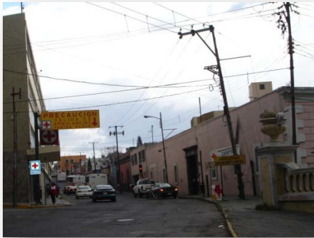
Imagen 140. Vista de cableado de red de electricidad y telefonía dañando la imagen urbana. Contiguo a zona 2
