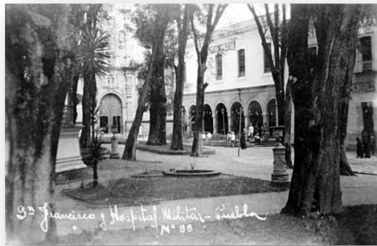
Imagen 13. Vista de exterior del templo de San Francisco
