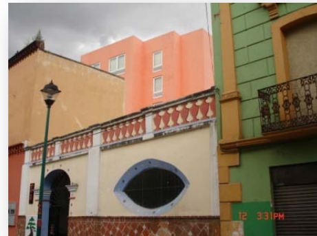
Imagen 105. Vista de fachada de los Lavaderos de Almoloya. Inmueble antiguo utilizado ocasionalmente para exposiciones artísticas.
