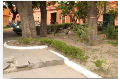
Imagen 76. Vista de área verde carente de mantenimiento con árboles viejos no apreciados. Zona 4
