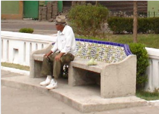
Imagen 288. Vista de mobiliario de descanso a dar mantenimiento ubicado alrededor de la fuente de los azulejos en la zona 4.
