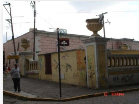
Imagen 233. Vista de imagen urbana (Toponegligencia al lugar y deterioro por grafitis). Zona 2
