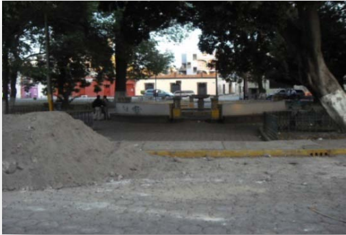
Imagen 174. Vista de mobiliario. Fuente en deterioro e impactando a la imagen urbana.
