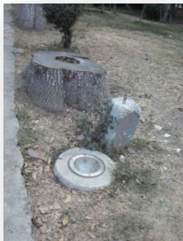
Imagen 178. Vista de mobiliario. Luminarias en nivel de piso colocadas en áreas verdes para iluminación de algunos árboles. La iluminación es de colores, el servicio de iluminación es insuficiente. Ubicadas en zona 3
