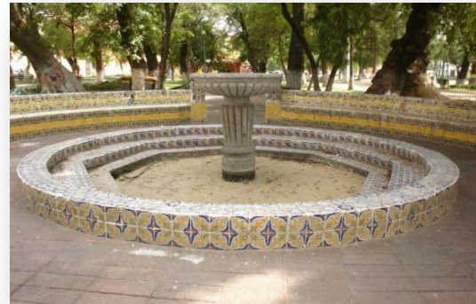
Imagen 173. Vista de mobiliario. Fuente erigida al poeta Rafael Cabrera, está en deterioro excesivo y con grafiti de pintura en aerosol, no funciona, está ubicada en la zona 3
