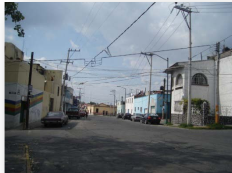
Imagen 137. Vista de cableado de redes de electricidad y telefonía afectando la imagen urbana. Contiguo a zona 1
