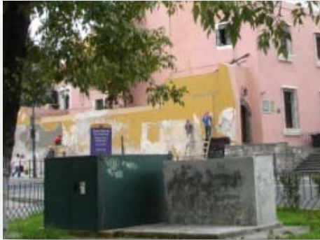
Imagen 210. Vista de infraestructura (red de electricidad). Zona 4
