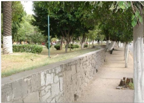
Imagen 190. Vista de vialidad peatonal en el límite con el contexto conjunto al Blvd. 5 de Mayo. Falta de accesibilidad para circular. Zona 2
