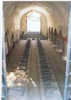
Imagen 104. Vista de antiguos lavaderos de Almoloya, inmueble del siglo XVIII. Equipamiento cultural del contexto, contiguo a la zona 4
