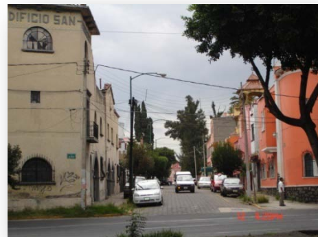
Imagen 143. Vista de cableado de redes de electricidad y telefonía, afectando la imagen urbana. Contiguo a zona 3
