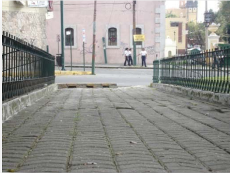
Imagen 198. Vista de infraestructura (alcantarillado). Zona 1
