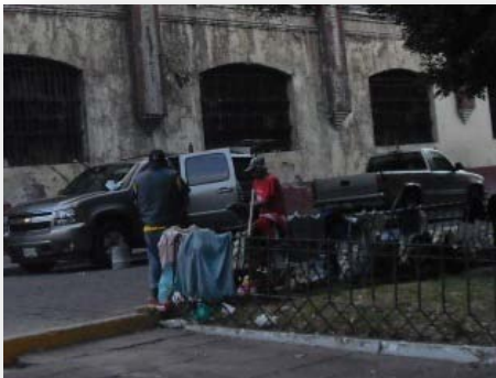
Imagen 249. Vista de aspecto social (apropiación del espacio público y deterioros). Afectaciones a la imagen urbana e impacto social en el uso del Parque. Zona 2 y 3
