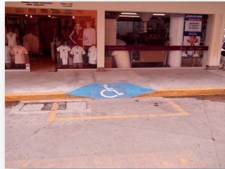
Imagen 266. Vista de rampa con pendiente continua sin bordes en el cambio de nivel de las vialidades para facilitar la accesibilidad. Villahermosa, Tabasco.
