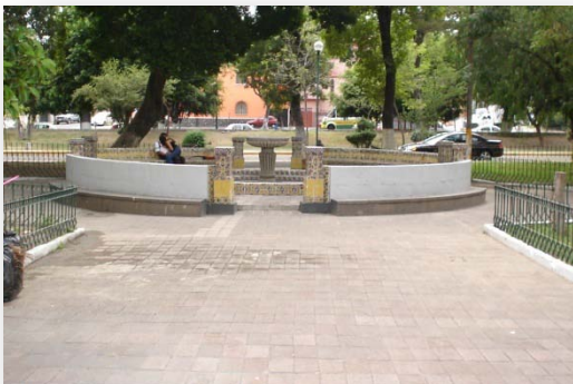
Imagen 313. Vista del estado actual de la fuente circular de azulejo. Se propone darle mantenimiento, restaurarla, mejorar la base y reemplazar el material del piso, colocar iluminación para enfatizarla.
