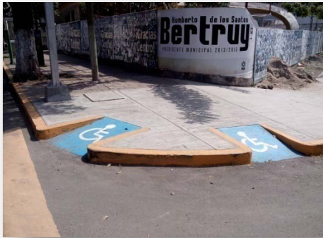
Imagen 265. Vista de rampas en esquina de calle para personas con discapacidad. Villahermosa, Tabasco.
