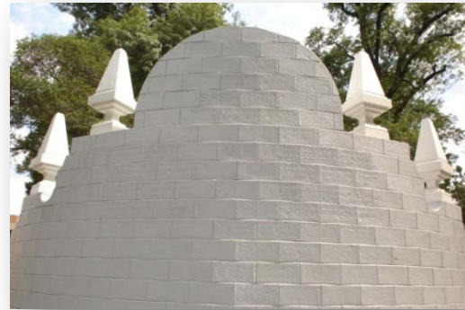
Imagen 169. Vista posterior de mobiliario. Hemiciclo erigido a Rafael Cabrera, presenta falta de mantenimiento para su conservación. Tiene un fragmento cincelado de una composición de épicas estrofas a los niños héroes de Chapultepec. Ubicado en la zona 2
