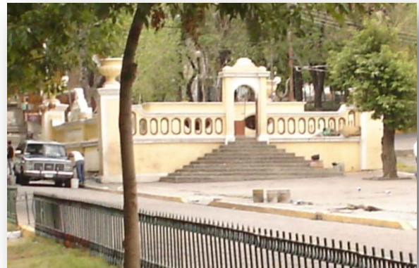
Imagen 274. Vista de acceso a estructura de bombas para dar mantenimiento y pintar fachada. Zona 2
