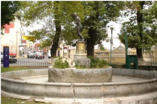
Imagen 172. Vista de mobiliario. Fuente en deterioro, sin funcionar, sin placa informativa, ubicada del lado de la vialidad 20 Oriente, en la zona 2 dentro de área verde sin acceso.
