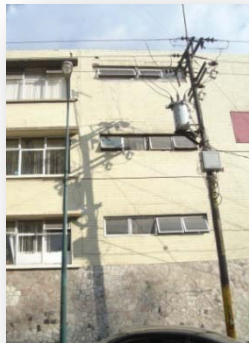
Imagen 136. Vista de red de electricidad Contiguo a zona 1
