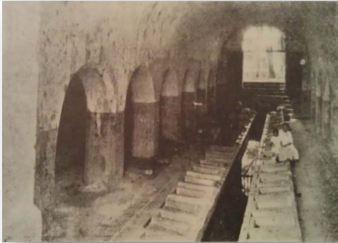
Imagen 4. Vista de los Lavaderos de Almoloya en uso. Fuente:
