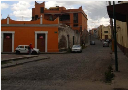
Imagen 126. Vista de vialidad vehicular de material de canto rodado deteriorado. Calle 18 Oriente, contigua a zona 2
