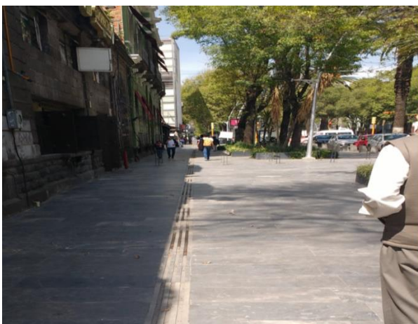
Figura 2.13.2.9.- Avenida Juárez después de los trabajos realizados por la actual administración en éste año (2018), se renovaron por completo sus calles, desde los pisos de las aceras, quedando a nivel del arroyo vehicular, se colocó nueva guía para débiles visuales. Fuente: Archivo fotográfico propio
