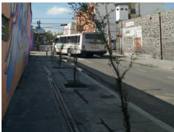
Figura 2.13.2.13. - Se amplió la calle, se colocó guía para débiles visuales y vegetación nueva. Fuente: Archivo Fotográfico propio.
