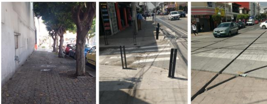
Figura 2.13.2.11.- Zona D Paso peatonal y aceras en tramos de la Calle 19 Sur. Se observa buen estado de banquetas y accesos.
