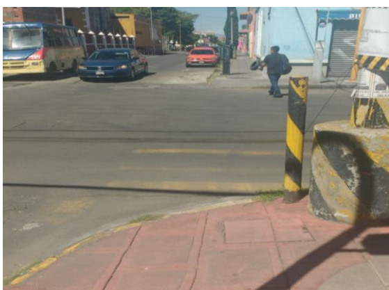
Figura 2.13.2.6.- Rampa en esquina 13 sur y 17 poniente. Fuente: Archivo Fotográfico propio.
