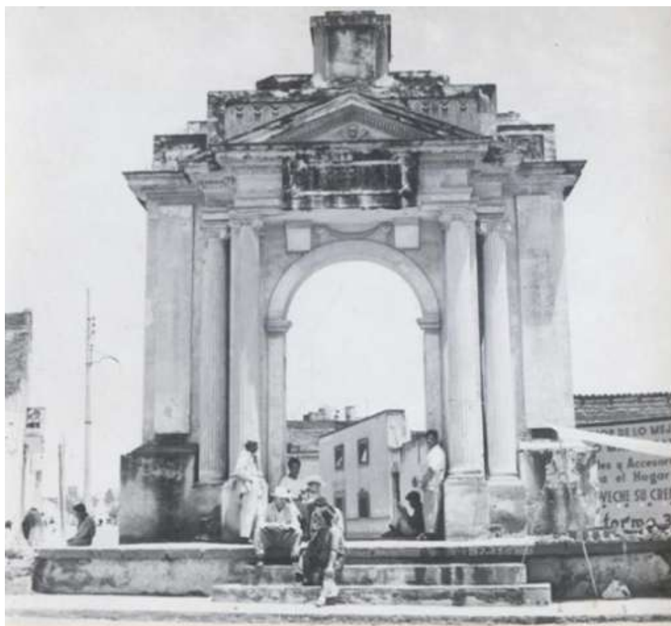
Figura 15 Anticuo arco de San Antonio (mitad del siglo XX). Entrada al ex cementerio de San Antonio, llamado por los vecinos "el arco del padrote", demolido años después de sacar la zona de tolerancia en 1957. Recuperada de http://radiobuap.com/2017/11/la-ciudad-sitiada-por-los-muertos-panteones-poblanos-en-el-siglo-xix/ . Julio, 2019
