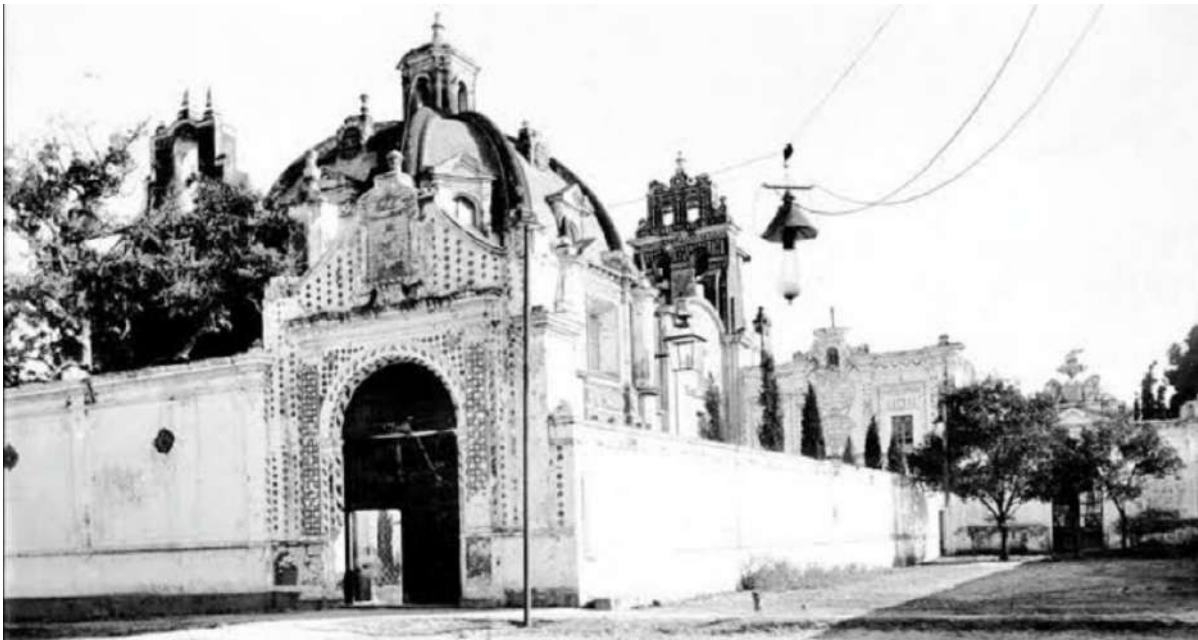
Figura 13. Imagen tomada en el año de 1880, podemos ver la entrada del cementerio del Carmen, distinguiendo las dos esculturas de la portada conocidas como “las comadres”. Recuperada de https://www.facebook.com/PueblaAntigua/posts/en-esta-toma-de-ca-1880-por-fin-podemos-ver-la-entrada-del-cementerio-del-carmen/1659578210778397/ . Julio, 2019
