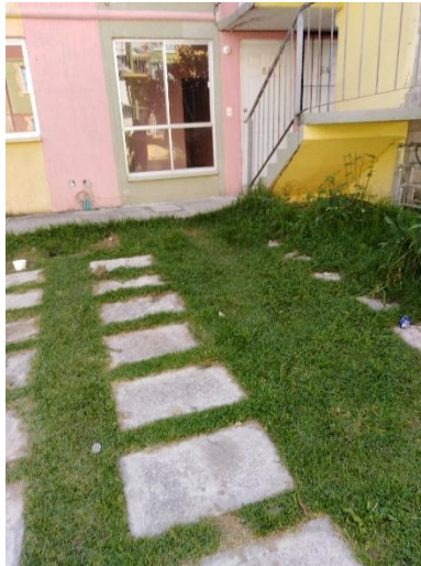
Fotografía 14. Viviendas de la Sección 5 b en abandono. (Fuente: ACV, 2018)
