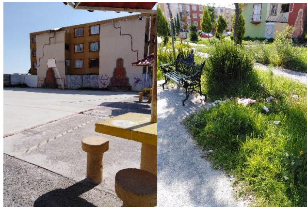
Fotografía 13. Vandalismo y falta de mantenimiento en áreas compartidas de la Sección 5b. (Fuente: ACV, 2019)
