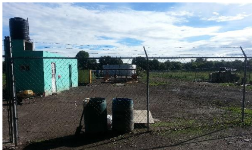
Fotografía 5. Planta tratadora Misiones de San Francisco. (Fuente: ACV, 2017)
