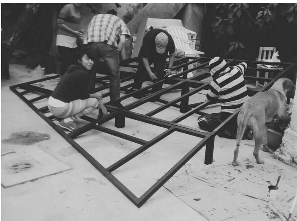
Fig. 4.3 Construcción de la estructura escenográfica.
