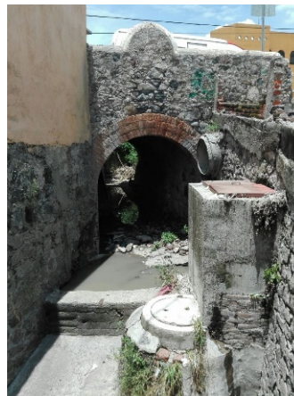
Foto 18: Entubamiento y canalización de barranca.
