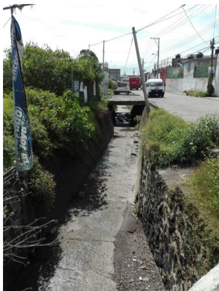
Foto 19: Canalización y reducción de barrancas impidiendo filtración de agua.
