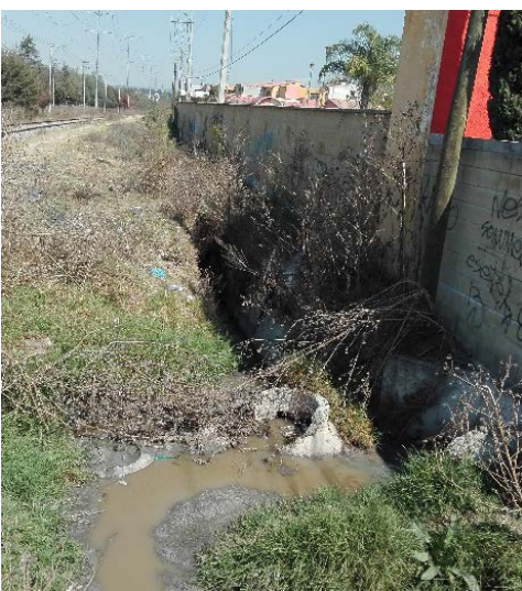
Foto 3: Barranca San Lorenzo Almecatla. Construcción invadiendo zona federal de la barranca.
