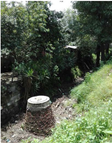
Foto 13: Perdida de vegetación.
