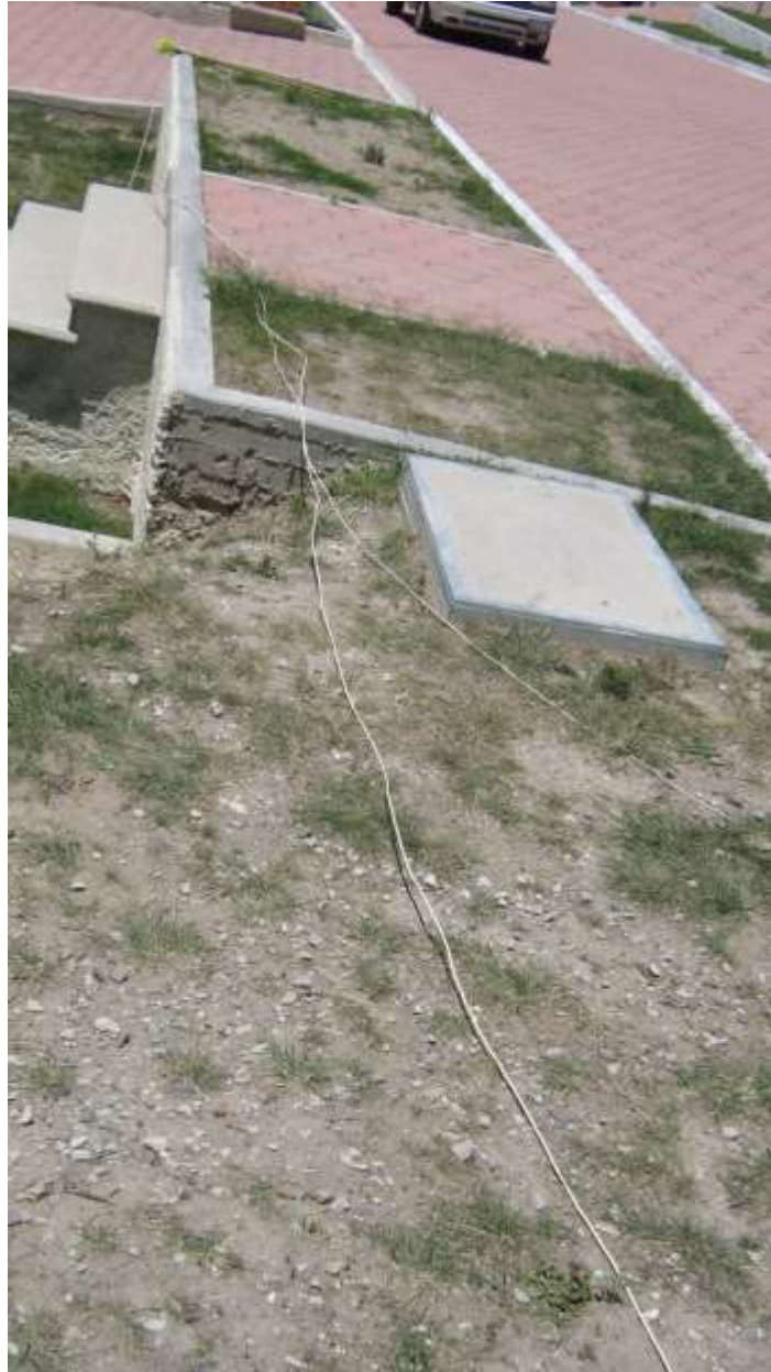
De las instalaciones
