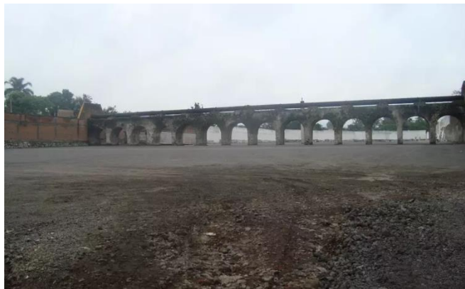
Ilustración 52. Acueducto de la fábrica de Cerritos. 2009. Ilustración tomada por Leonel Vélez
