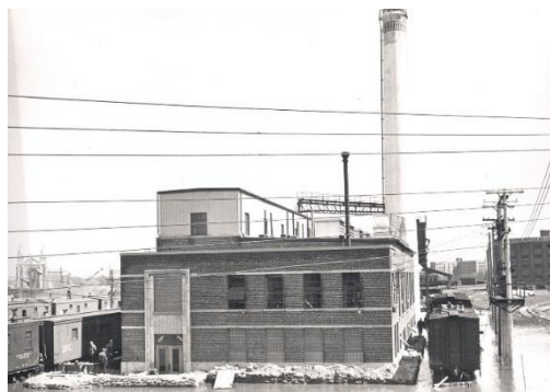
Ilustración 80. Antigua imagen de la parte norte de la planta. Winnipeg Architecture Foundation.
