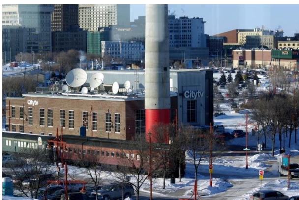
Ilustración 84. Actual edificio de la emisora Citytv. Fuente: Winnipeg Architecture Foundation.
