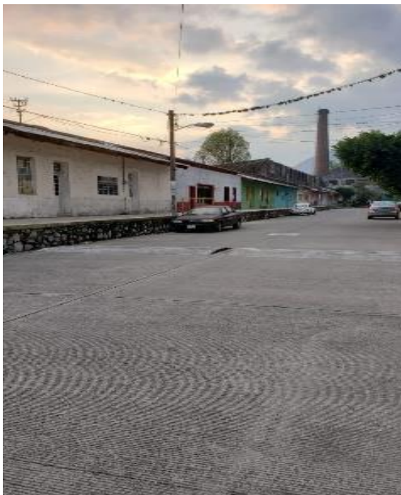
Ilustración 46 Rampa en Calle Constituyentes. 2021. Fotografía por Alexis Rebollo
