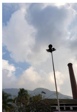
Ilustración 39. Luminaria pública. 2021. Fotografía tomada por Alexis Rebollo
