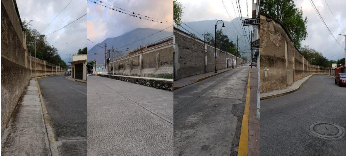
Ilustración 47. Vialidades colindantes a la ex fábrica Santa Rosa (análisis de accesibilidad). 2021. Fotografía tomada por Alexis Rebollo.
