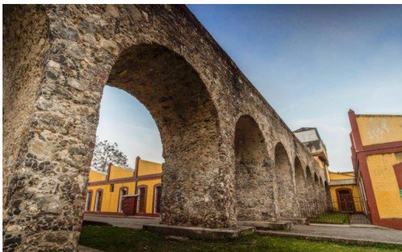
Ilustración 55. Acueducto y naves industriales del mercado Cerritos. 2021. Ilustración tomada por Alexis Rebollo.
