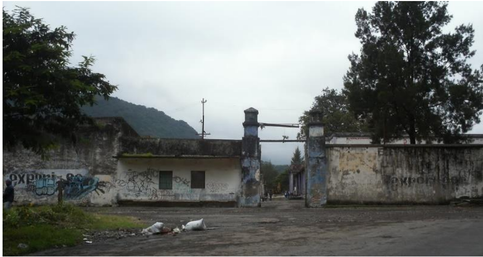
Ilustración 54. Entrada principal y muro exterior de la fábrica de Cerritos. 2009. Ilustración tomada por Leonel Vélez.
