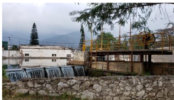
Ilustración 34. Hidroeléctrica y presa Santa Rosa. 2021. Fotografía tomada por Alexis Rebollo.
