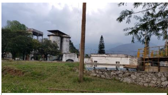
Ilustración 33. Hidroeléctrica y presa Santa Rosa. 2021. Fotografía tomada por Alexis Rebollo.
