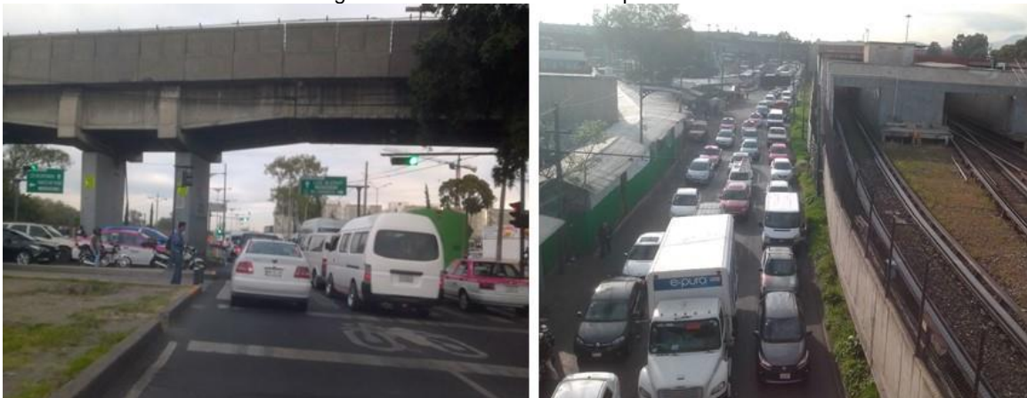
Figura No. 23: Problemas de Capacidad Vial
